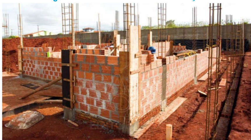
Figura 1 - Sistema de alvenaria de vedação.
