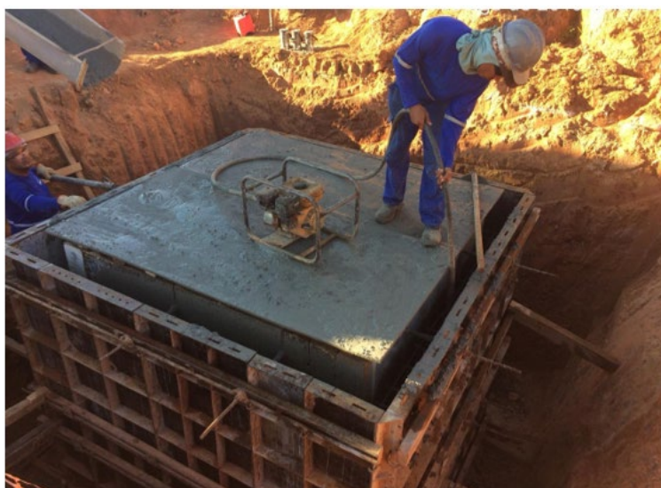
Figura 7 - Vibração do concreto
