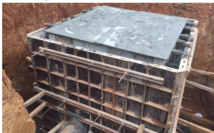
Figura 6 - Fôrma com painel metálico
