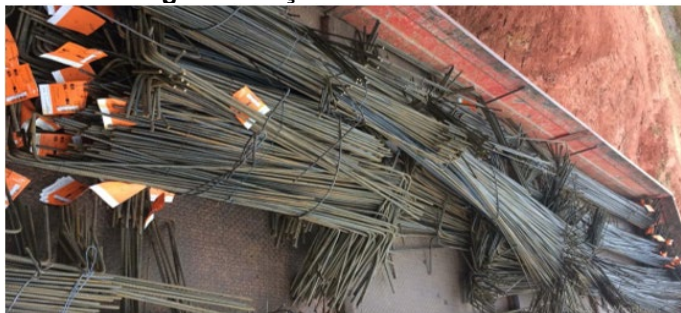
Figura 4 - Aço cortado e dobrado
