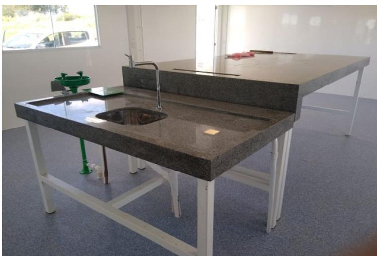
O piso e os rodapés serão revestidos em manta vinílica , sendo que todas as junções deverão ser soldadas a fim de evitar passagem de umidade para o compensado.
