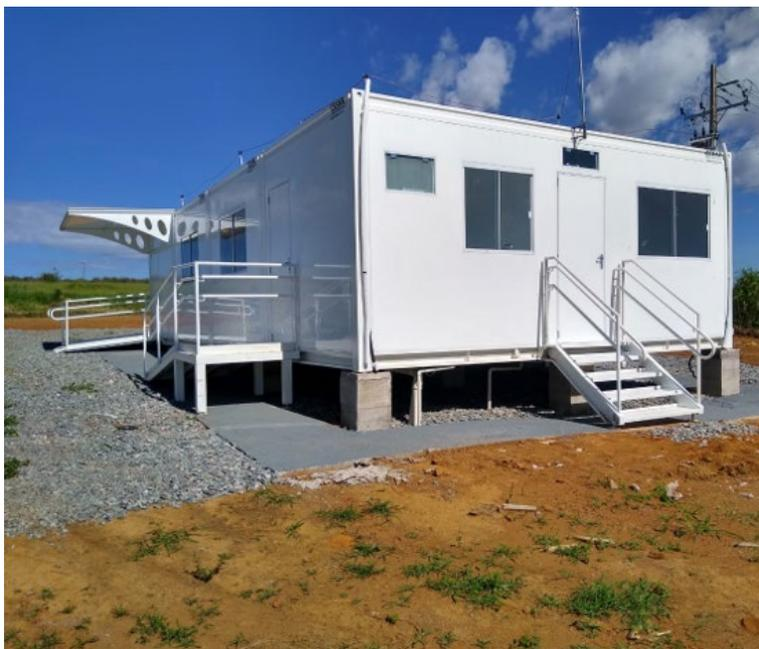
Foi feita a limpeza do local e regularização do terreno que servirá de apoio dos módulos habitacionais um radier com tela de aço soldada nervurada, com calçada em todo o perímetro da edificação com 1 metro de largura.
