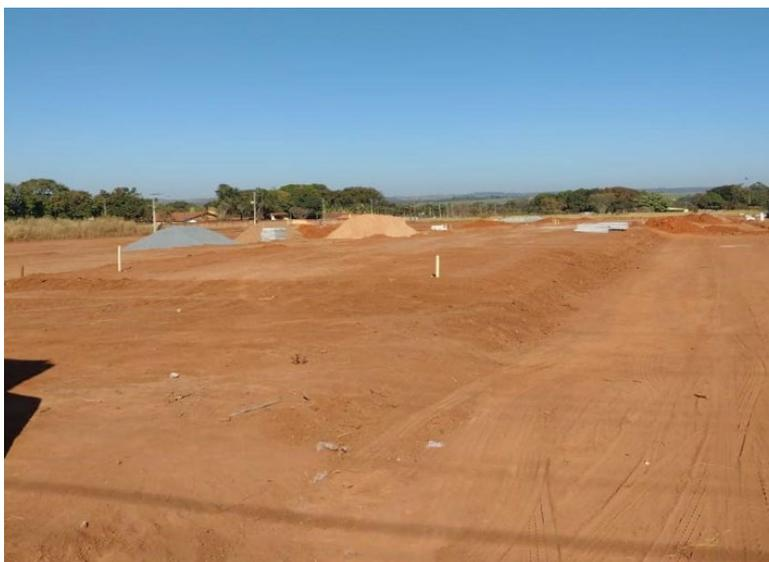
Assim que o solo estiver pronto e já com os dados do local verificar em qual tipo de fundação seria a melhor escolha, pelo o container em si não ser de grande peso como uma casa em alvenaria normal mente e feita uma fundação simples de uma sapata com profundidade de 1 metro aonde já seria o suficiente.
