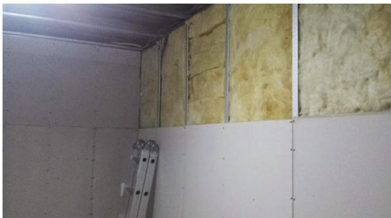
**Figura 9 - Instalação do drywall com isolamento térmico de lã de pet, instalação elétrica**
