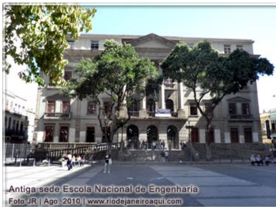
Escola Nacional de Engenharia, no Largo São Francisco.
