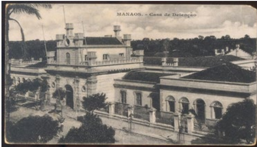
Figura 1 - A Casa de Detenção
