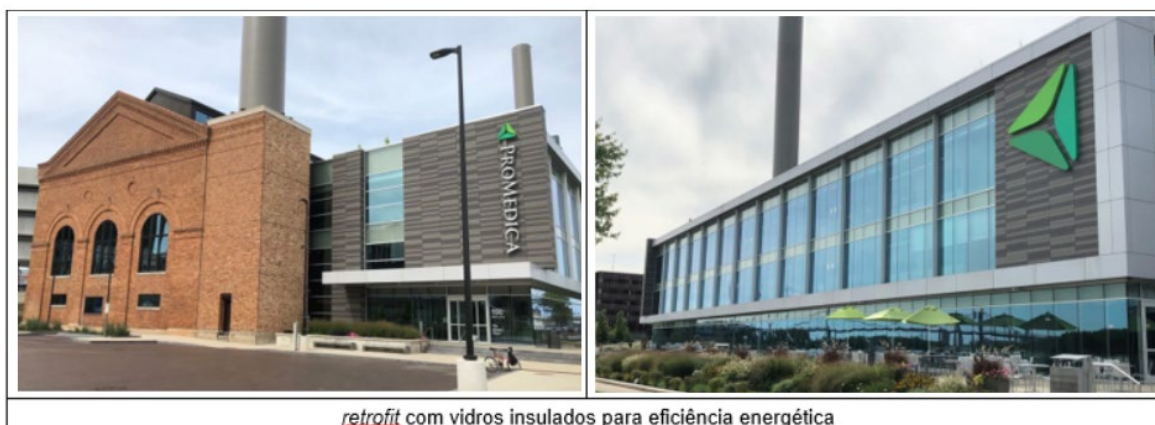
Figura 3 - Vistas de exemplo de retrofit para eficiência energética em edifício institucional em Toledo, Ohio, Estados Unidos
