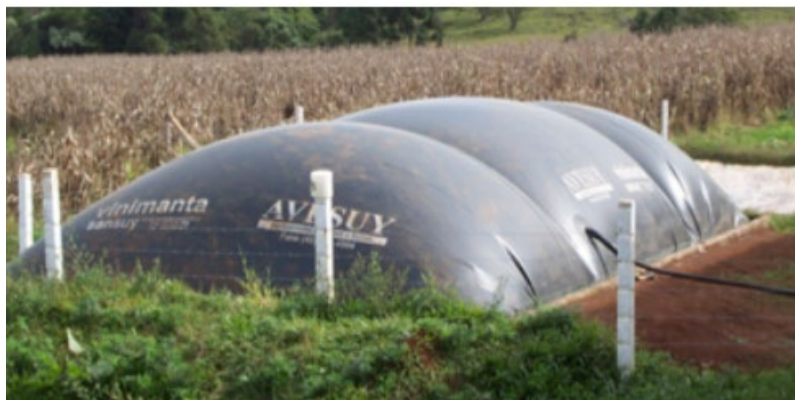
Figura 1 - Biodigestor em operação
