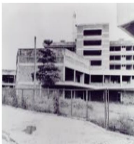
Figura 1 – Início da construção 1985
