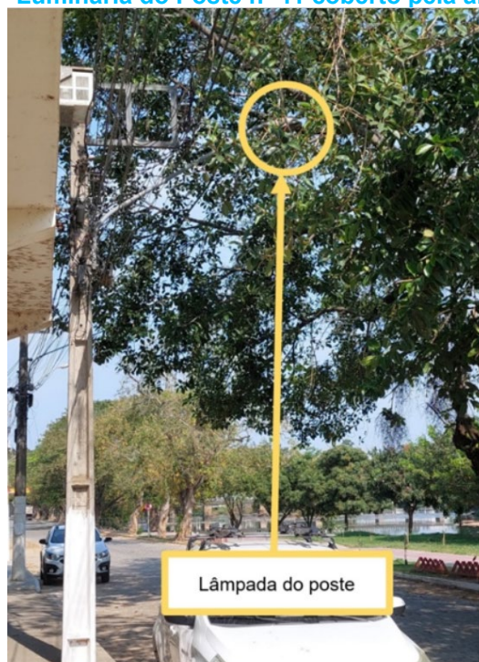
Figura 6 – Luminária do Poste nº 11 coberto pela arborização
