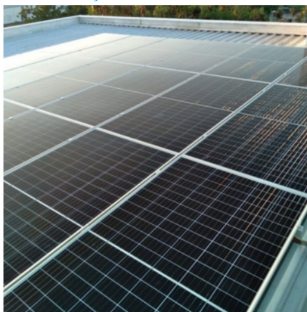
Figura 21 - Instalação do sistema fotovoltaico de 12kWp.
