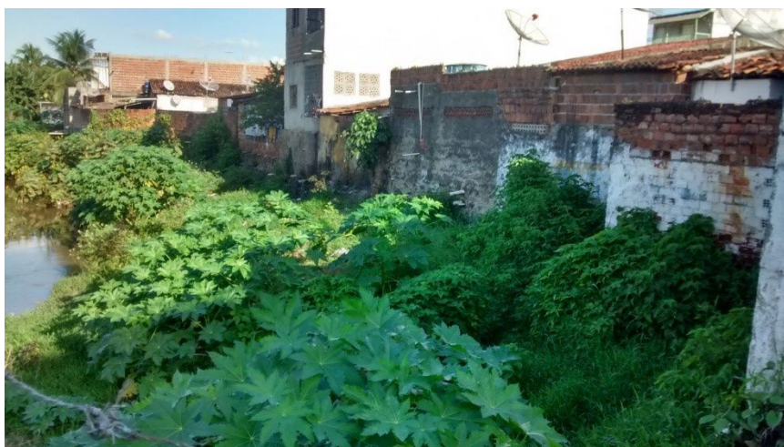
Figura 2 - Efluentes domésticos canalizados para Rio Guarabira/PB
