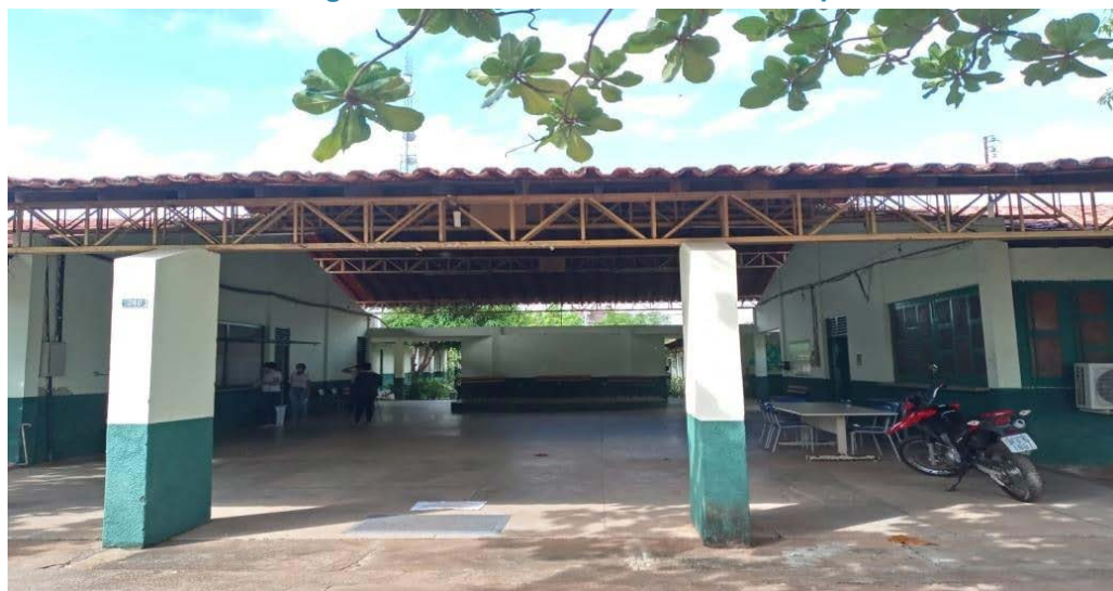
Figura 2 - Parte interna da escola campo
