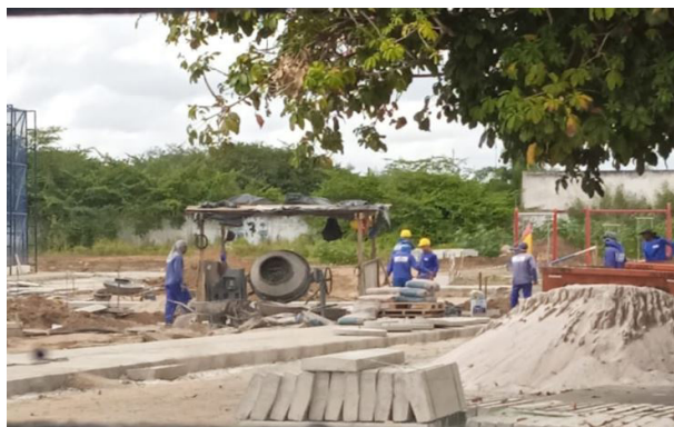
Figura 1 - Profissionais utilizando betoneira ao lado de salas de aula.
