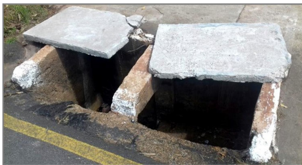
Figura 8 – Boca de lobo (BLC 18) com tampas desalinhadas.
