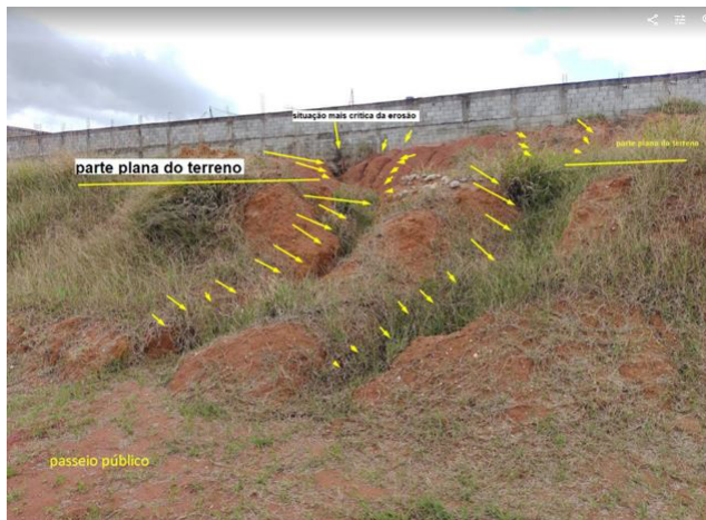
Foto 3 - Vista lateral do muro pela Rua lateral e Lote B.
