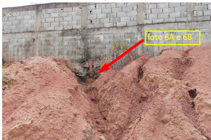
Foto 6 – Outro ponto de erosão.
