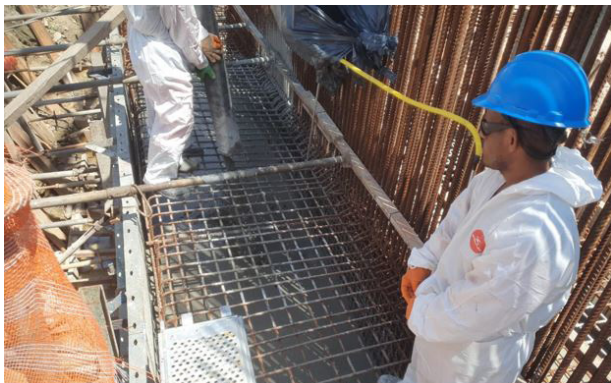
Figura 5 - Dispositivo de monitoramento para estrutura de concreto.
