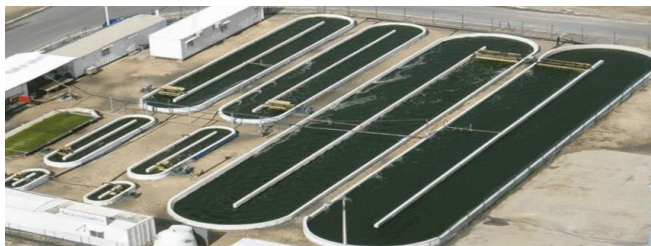
Figura 5 - Tanques com canais para cultivo de microalgas (sistema raceway).
