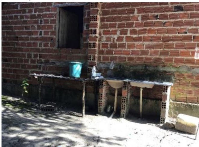
Figura 18 - Área de serviço habitação Fulkaxó.
