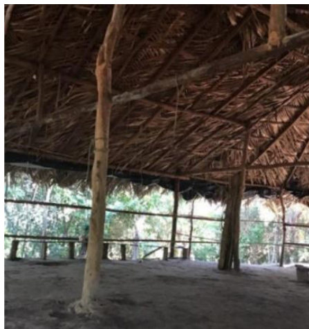
Figura 21 - Estrutura da cobertura na oca Fulkaxó.
