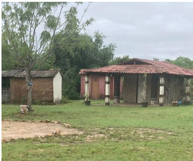
Figura 15 - Habitação Kariri-Xocó com abertura na cobertura.
