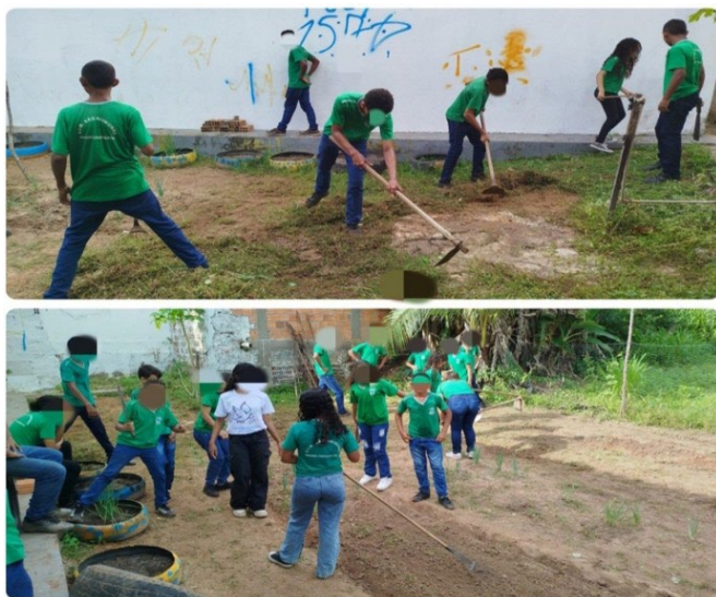
Figura 1 - Limpeza do solo e construção dos canteiros na escola São Raimundo.
