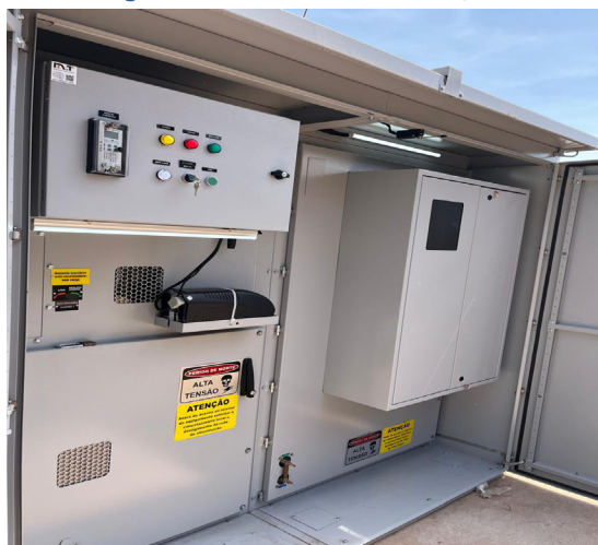
Figura 12 - Cubículo de medição.
