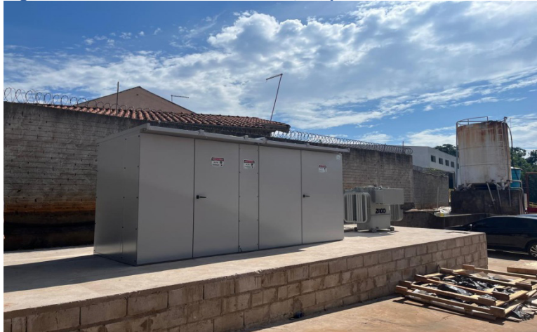
Figura 11 - Cabine blindada de medição, proteção e transformação.
