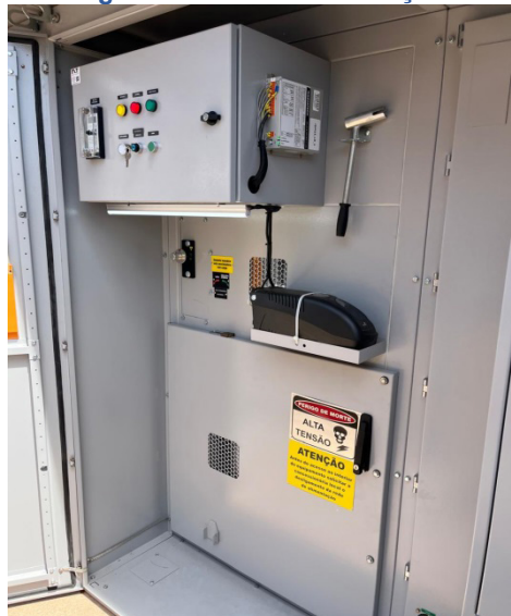
Figura 14 - Cubículo Proteção.
