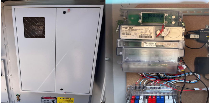
Figura 13 - Caixa de medição.
