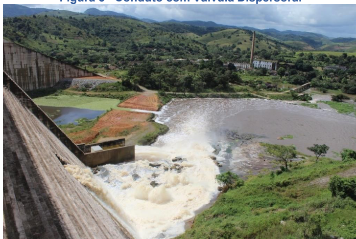
Figura 6 - Conduto com Válvula Dispersora.
