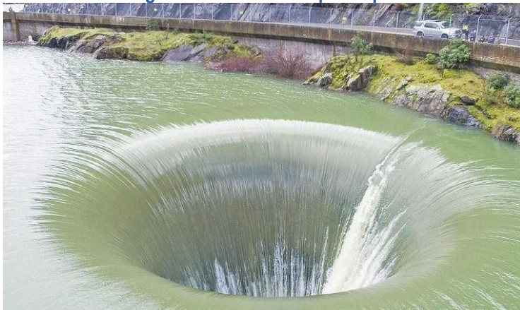
Figura 7 - Vertedouro Tipo Tulipa.
