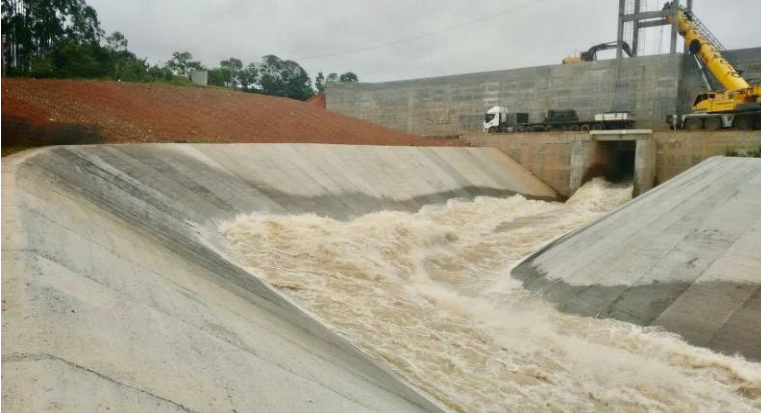
Figura 12 – Canal extravasor da Barragem de Taió.
