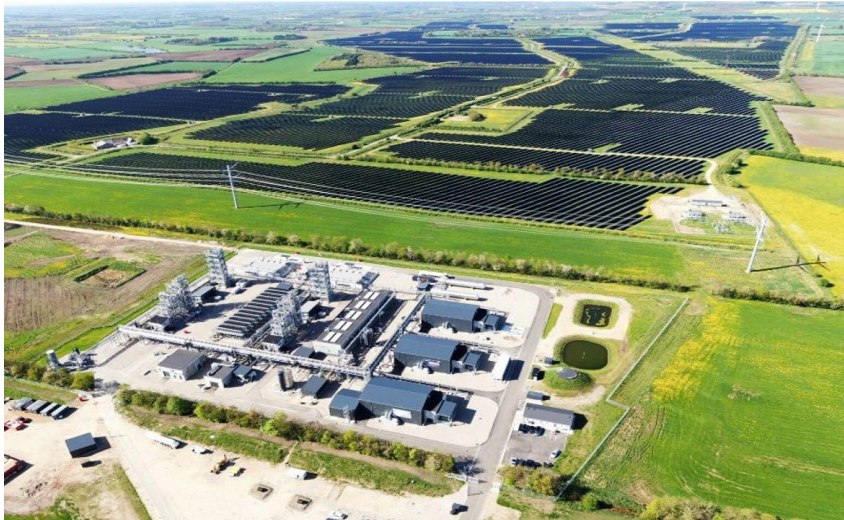
Figura 4 - A primeira instalação de e-Metanol (Kassø, Dinamarca).
