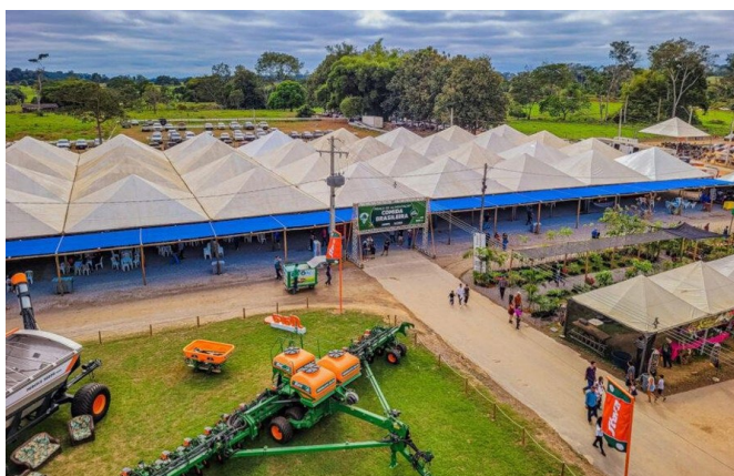
Figura 3 - Centro Tecnológico Vandeci Rack.
