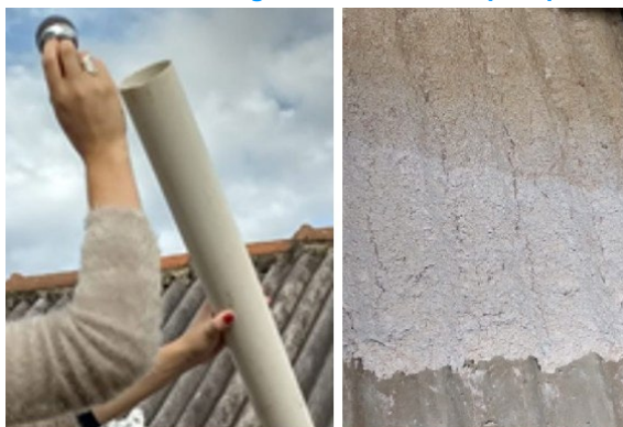
Figura 01 – Teste de carga sobre as telhas por queda livre.
