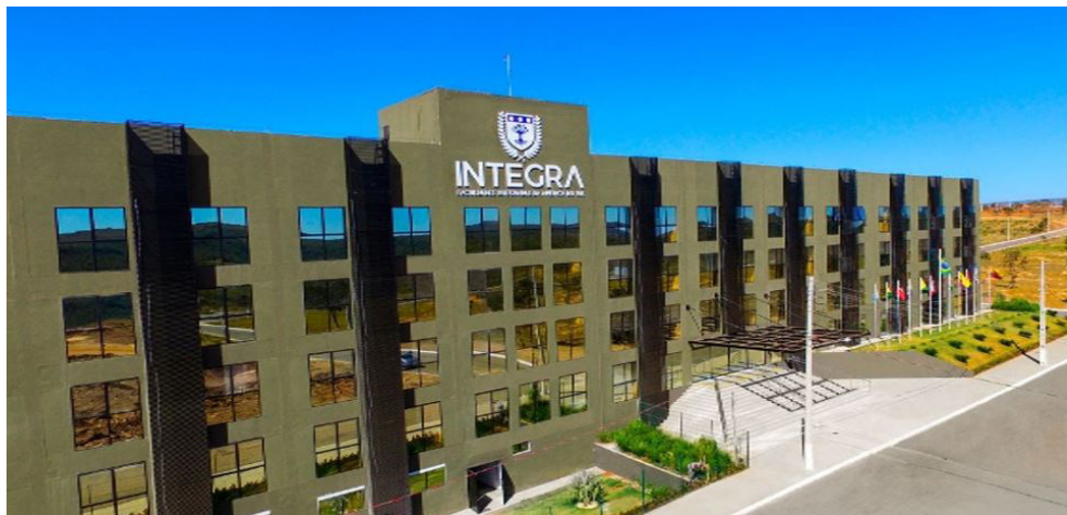
Figura 4 - Foto Bloco Principal Faculdade Integra.
