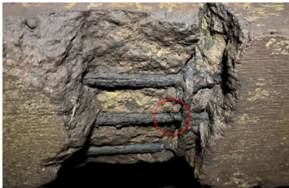
Figura 9 - Vista de armadura rompida devido a deformação e ingresso de agentes agressivos no reservatório B.
