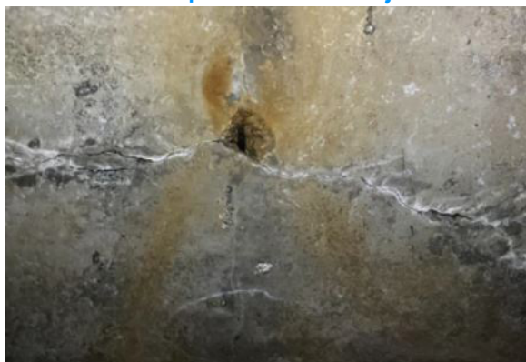
Figura 2 - Armaduras exposta e trinca na laje do reservatório A.
