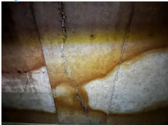
Figura 3 - Fissura ao longo da laje com presença de manchas ferruginosas devido à corrosão das armaduras no B.
