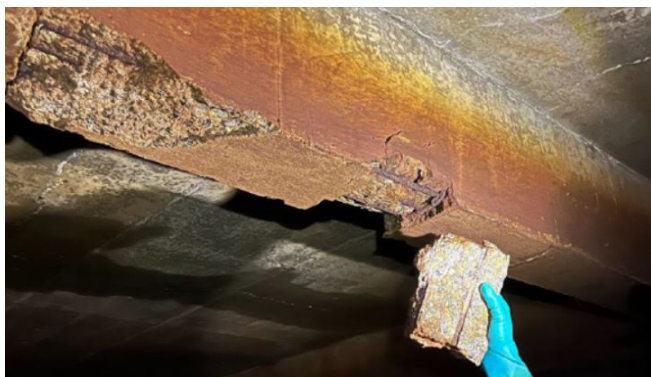
Figura 8 - Vista do deslocamento volumétrico de concreto no reservatório B.
