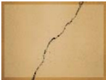
Figura 2.5 - Trincas
