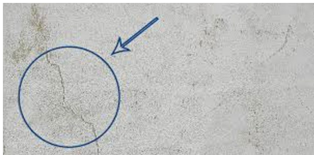
Figura 10 – Fissura.
