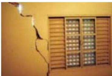
Figura 2.6 - Rachaduras
