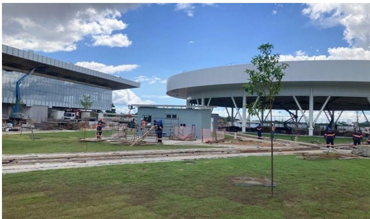
Fonte: Obras do Parque da Cidade, em Belém, onde ocorrerá a COP30 em novembro, estão sendo concluídas - Foto Fabiola Sinimbú.
