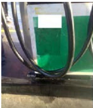
Figuras 14 e 15 - Vazamento de óleo combustível do bico da mangueira de abastecimento.
