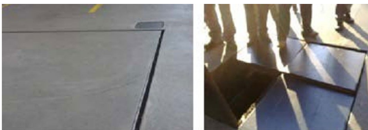
Figuras 12 e 13 - Canaletas e conjunto de separador de água de óleo.
