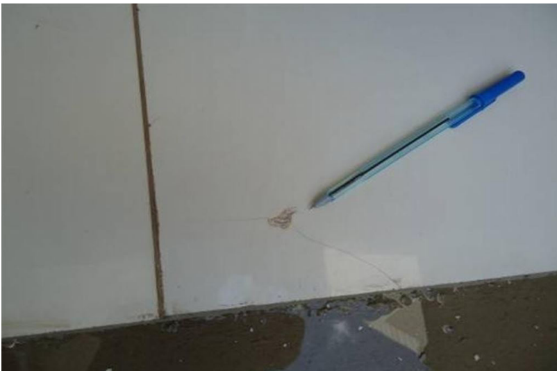
Figura 9 - Cerâmica danificada.
