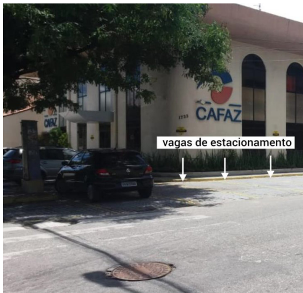
Figura 35 - Avenida Francisco Sá - Estacionamento construído sobre a Calçada.
