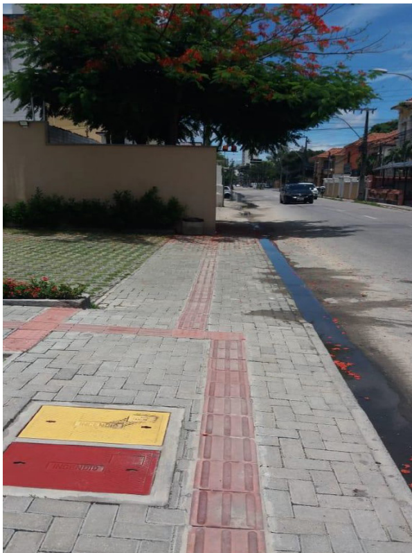
Figura 51 - Calçada do Condomínio Francisco Philomeno Residence.
