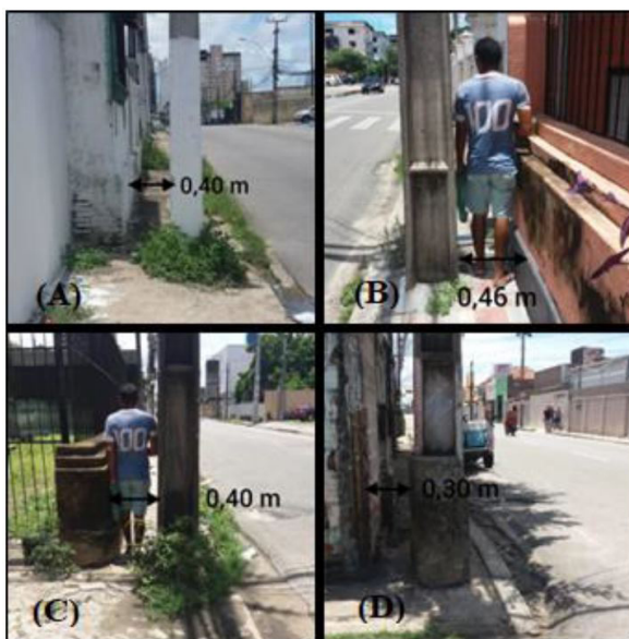
Figura 26 - Avenida Francisco Sá - Obstáculos nas Calçadas.
