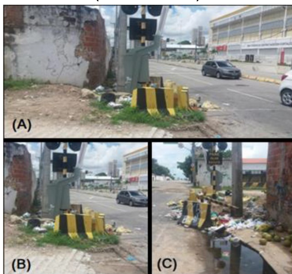
Figura 50 - Avenida Filomeno Gomes - Passagem de Nível (Linha do Férrea).
