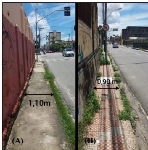
Figura 27 - Avenida Francisco Sá - Calçadas Estreitas.
