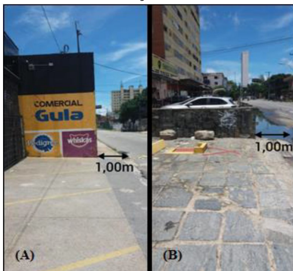
Figura 34 - Avenida Francisco Sá - Avanço sobre as Calçadas.
