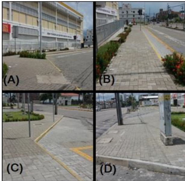
Figura 45 - Avenida Filomeno Gomes - Trecho no Centro Fasion Fortaleza.
