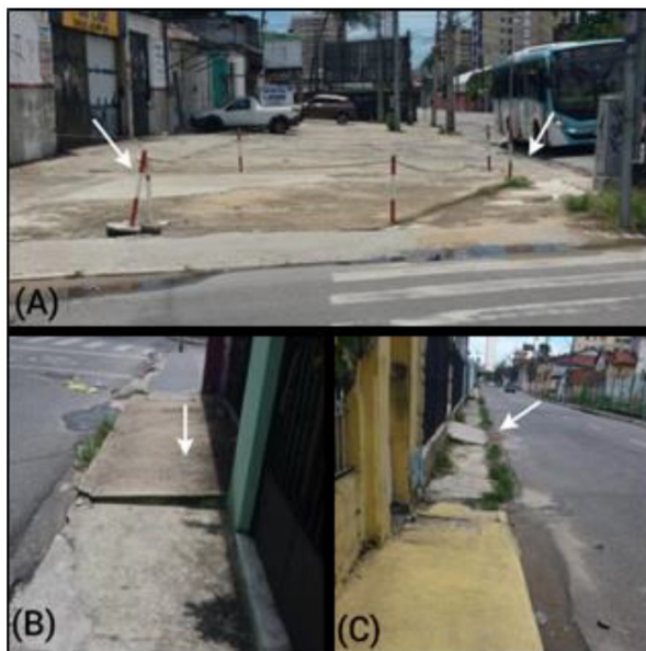
Figura 33 - Avenida Francisco Sá - Privatização e rampas sobre as calçadas.
