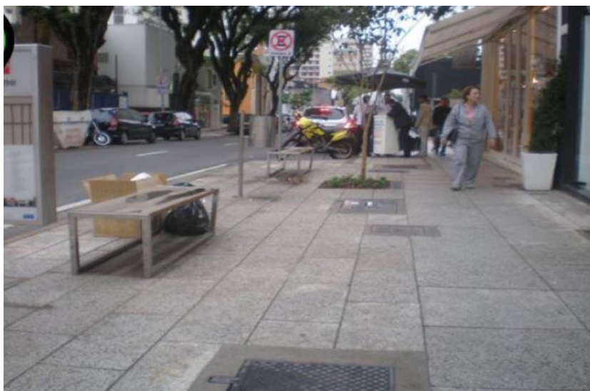
Figura 17 - Revestimento de Calçada - Placas de Concreto.
