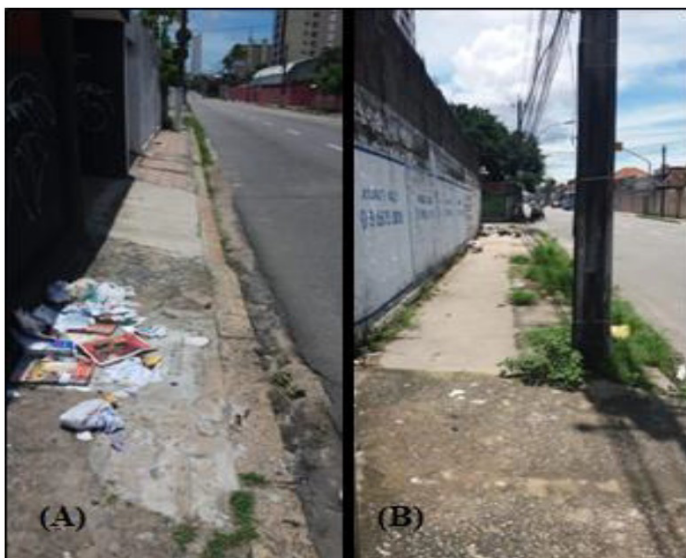
Figura 32 - Avenida Francisco Sá - Calçadas com Aspecto de Abandono.
