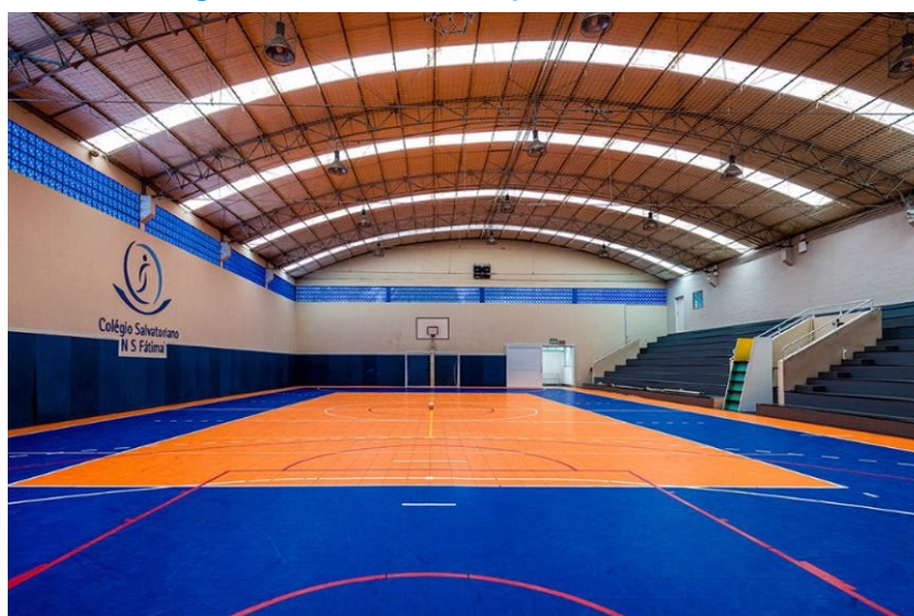
Figura 2 - Ginásio Poliesportivo do CSNSF.
