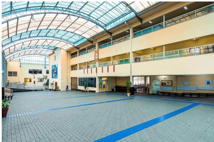
Figura 1 - Parte interna do CSNSF – Pátio Principal.
