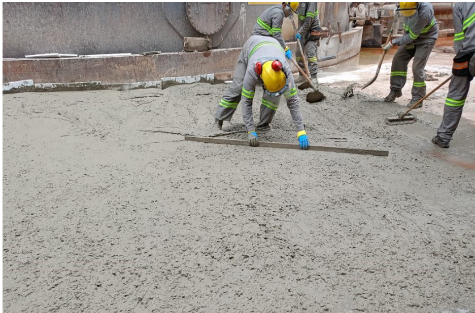
Figura 8- Concretagem.
