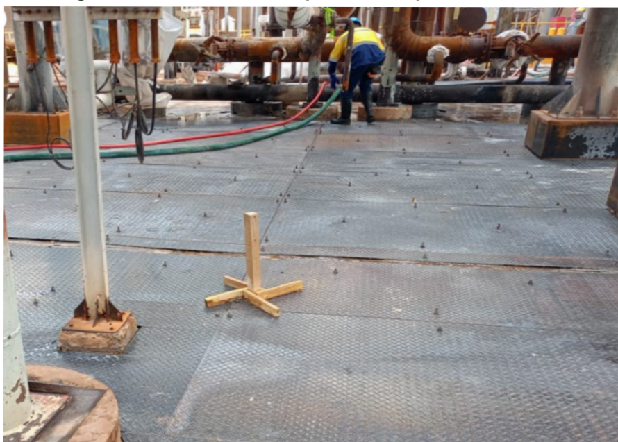
Figura 9 – Placas metálicas por cima do piso de concreto.
