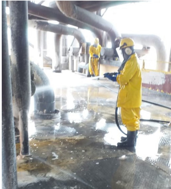
Figura 6 – Hidrojateamento para retirada de sujeira do concreto.
