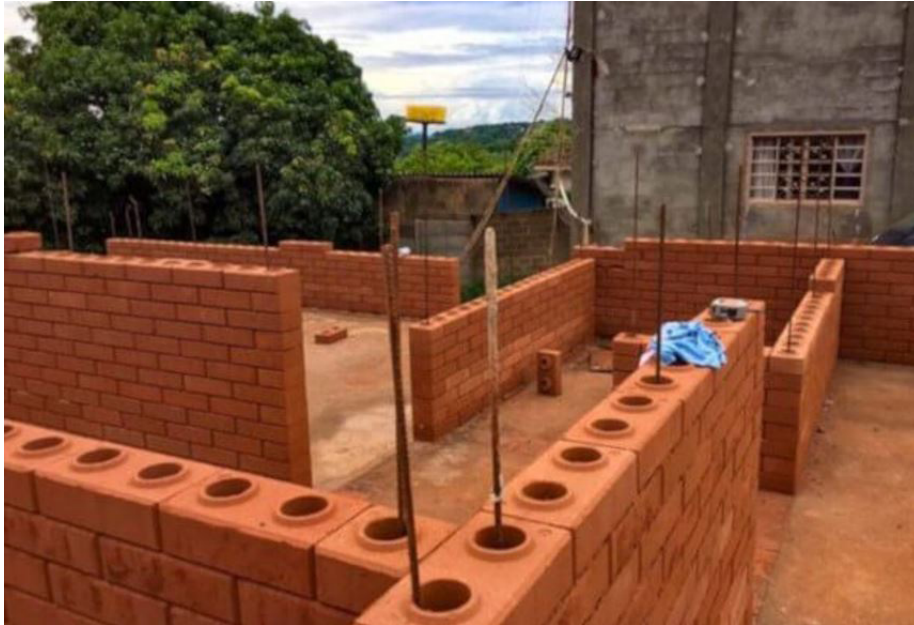
Figura 4 - Câmaras estanques de ar formadas nos tijolos ecológicos.
