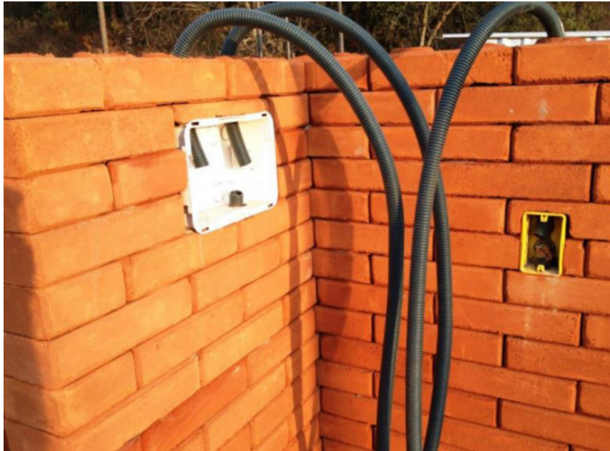
Figura 3 - Infraestrutura elétrica instalada em blocos de solo-cimento.
