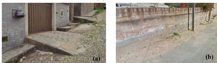
Figura 2 - Exemplos de calçadas irregulares na cidade: (a) rampas invadindo logradouro público, degraus impedindo acessibilidade; (b) ausência de calçada.
