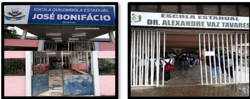
Figura 1 - Fachada das duas escolas pesquisadas.
