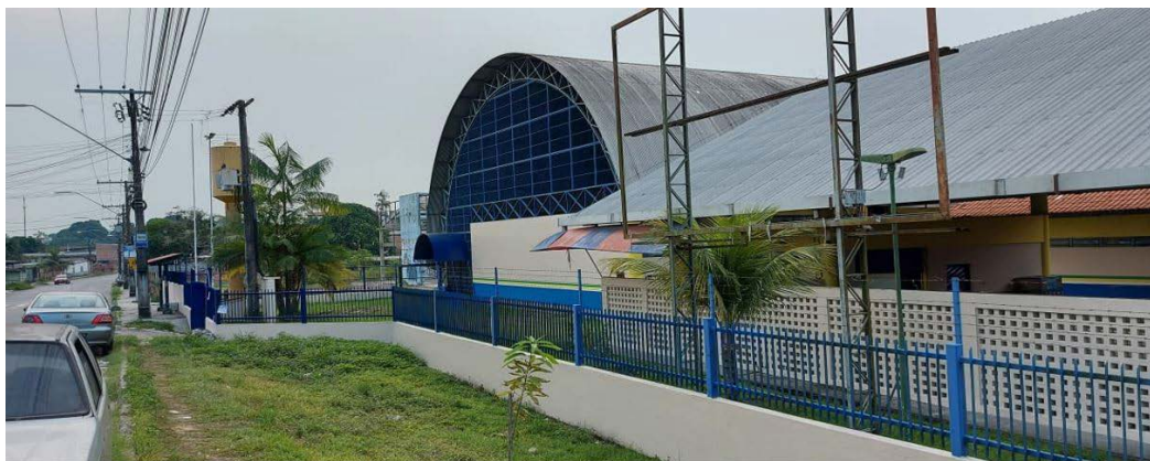
Figura 2 - Quadra Poliesportiva da E. E. Manoel Rodrigues de Souza.
