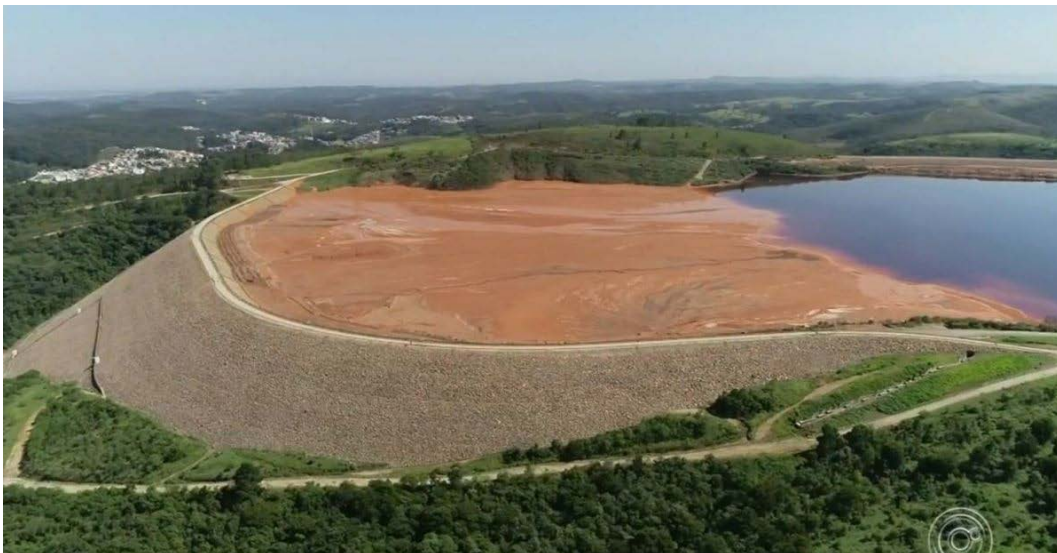
Figura 4 - Barragem de rejeitos.
