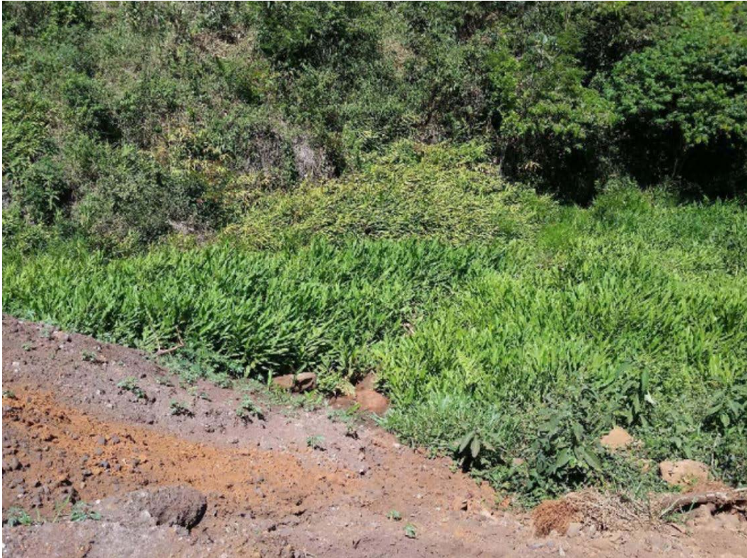
Figura 12 - Vegetação alta no pé do talude.
