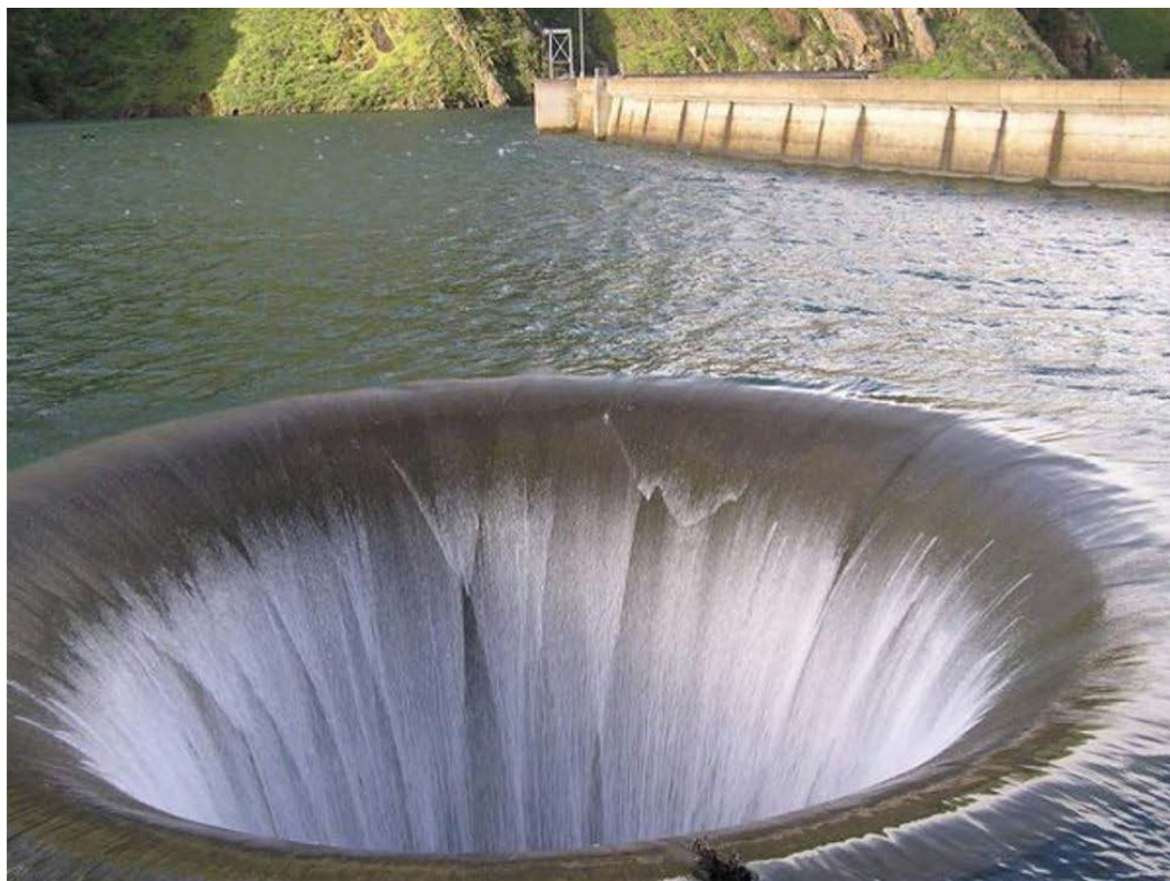
Figura 3 - Túnel de drenagem Tulipa.
