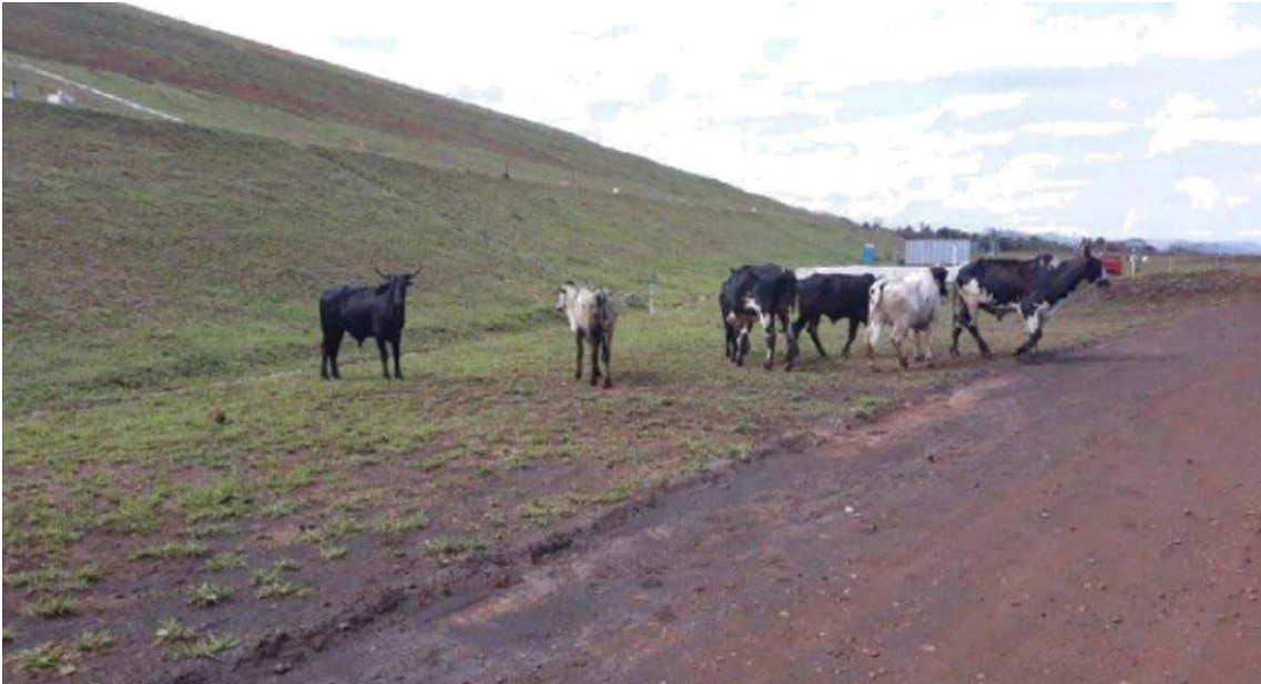
Figura 26 - Presença de gado no talude do barramento.
