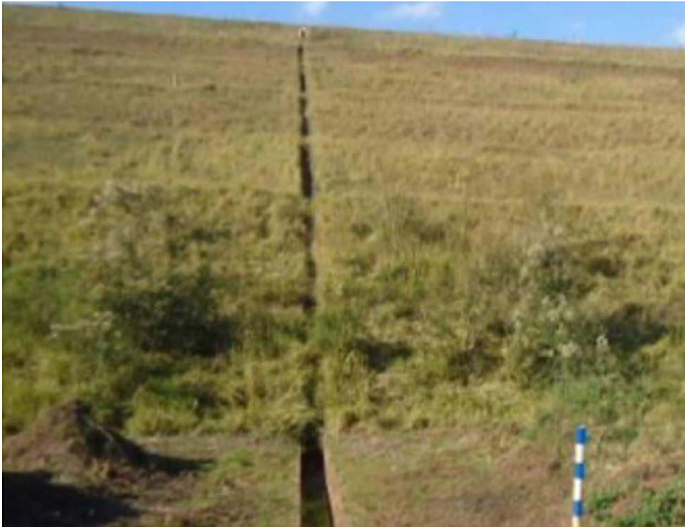
Figura 10 - Arbustos no talude.
