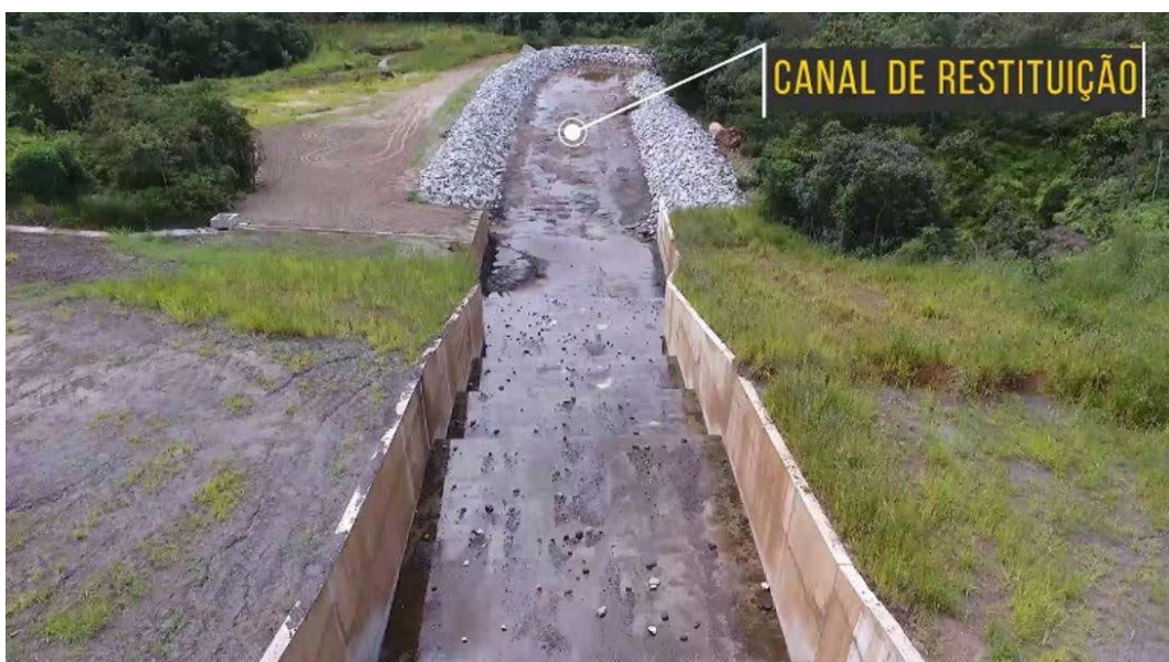
Figura 2 - Canal de restituição.
