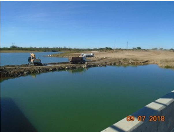
Foto 26 – Início da remoção da ensecadeira.
