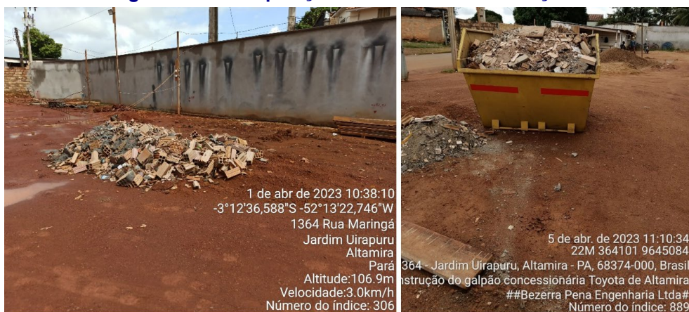
Figura 1 e 2 – Disposição de resíduos de demolição.
