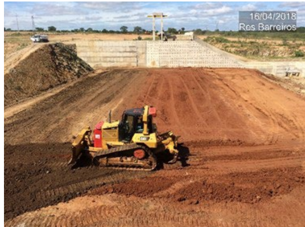
Foto 19 – Execução do aterro de recomposição do maciço
