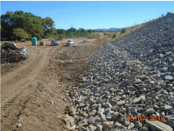
Foto 28 – Vista da proteção do talude a jusante.
