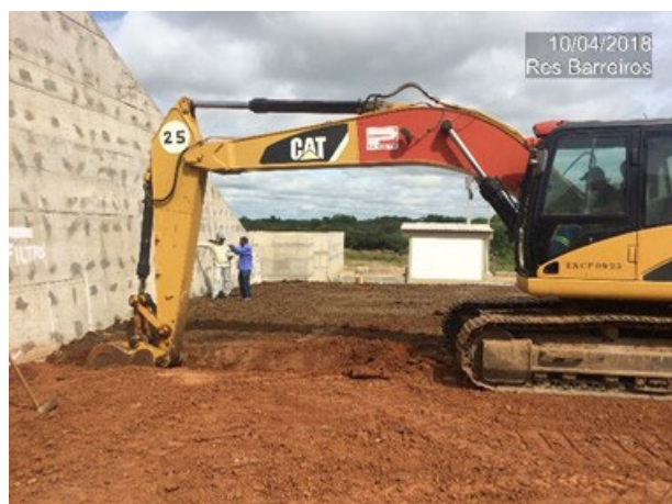
Foto 17 - Execução do filtro vertical.
