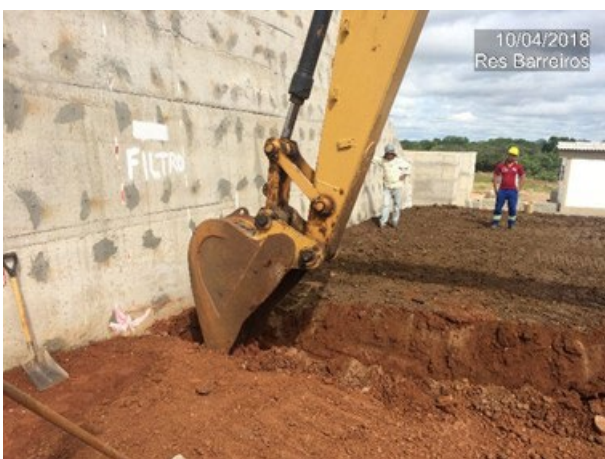
Foto 16 – Execução do filtro vertical.
