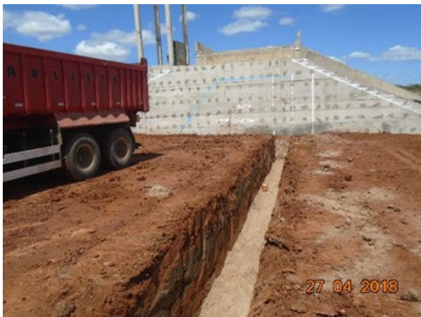
Foto 22 – Execução do filtro vertical
