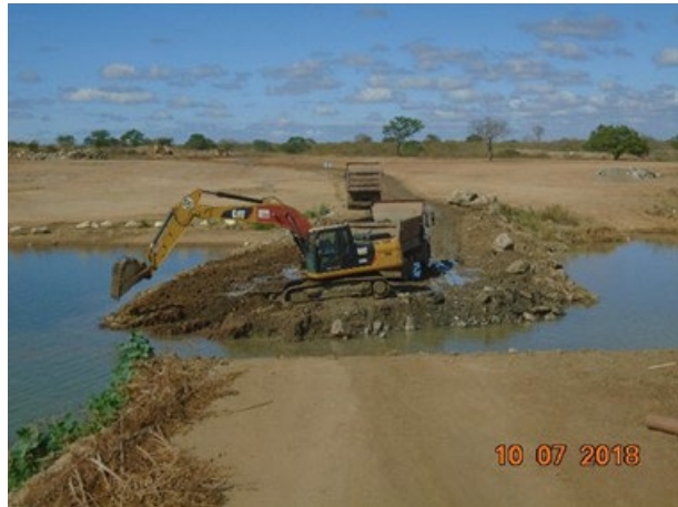
Foto 27 – Remoção da ensecadeira.
