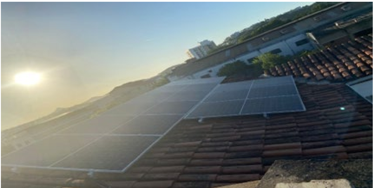
Figura 2 - Sistema de Energia Solar.
