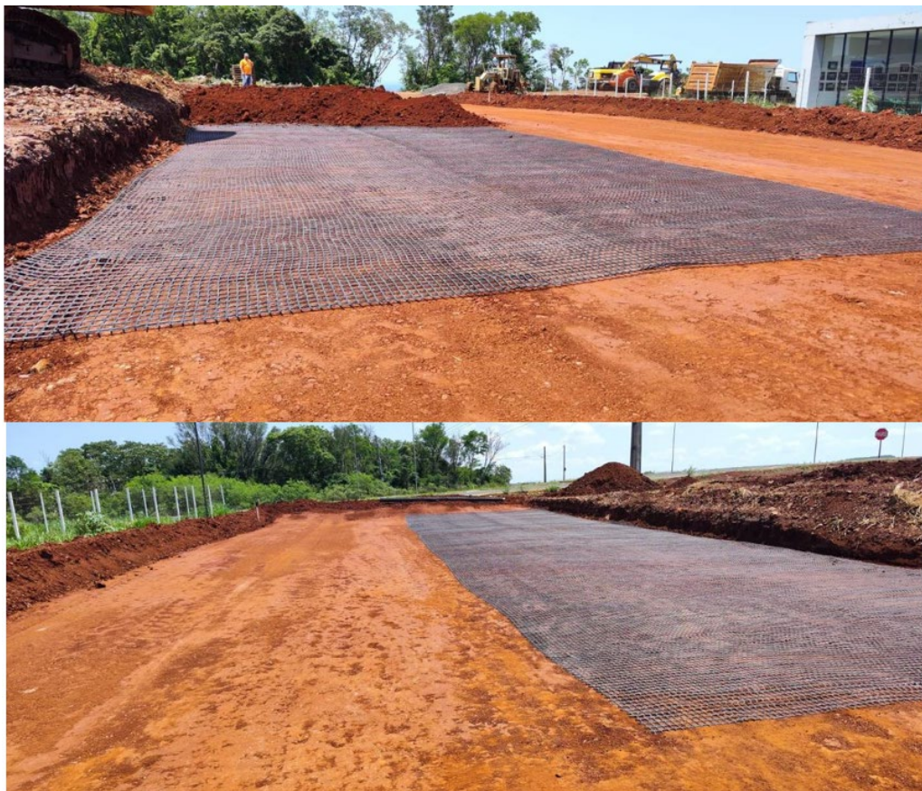
Figura 11 – Instalação da geogrelha.
