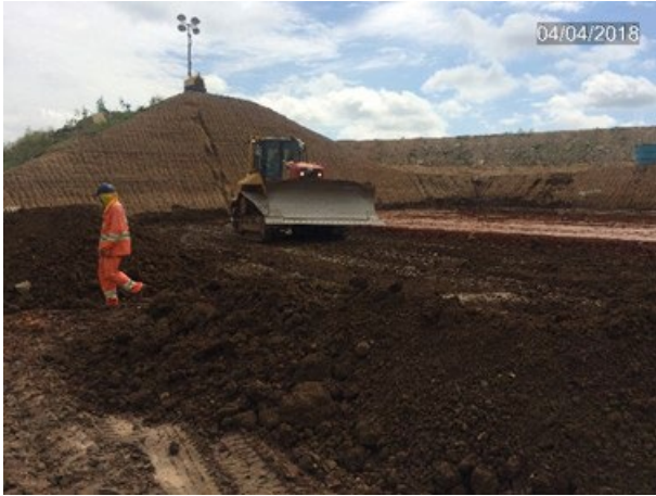
Foto 12 – Serviço de recomposição do maciço da barragem.
