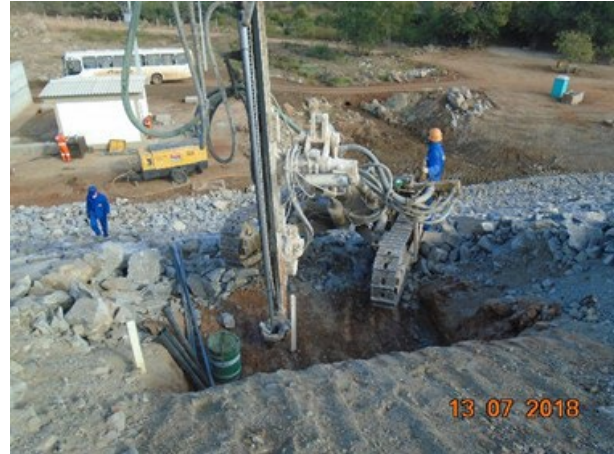
Foto 31 – Execução de instrumentação no paramento de jusante.
