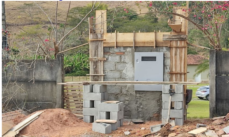
Figura 1 – Padrão em construção.
