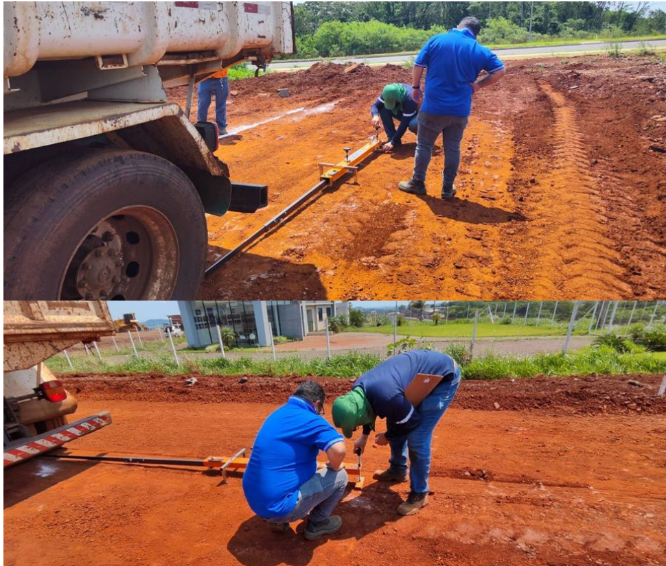
Figura 6 – Ensaio com a viga benkelman.
