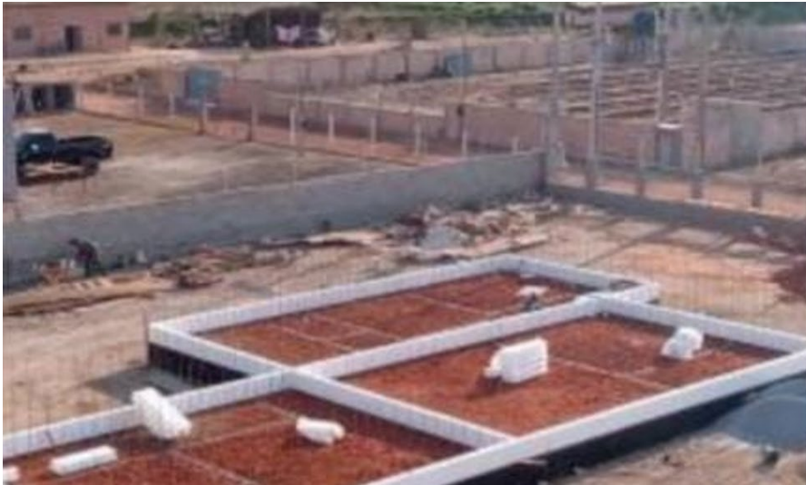
Figura 4 - Levantamento da primeira fiada das formas de EPS.
