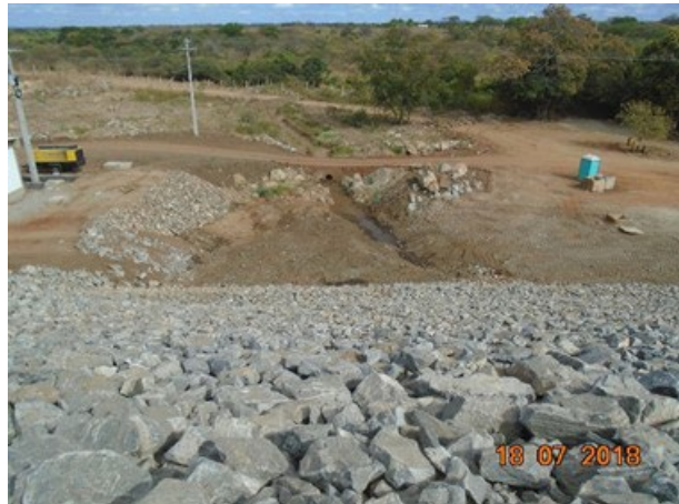
Foto 29 - Vista da proteção do talude a jusante.
