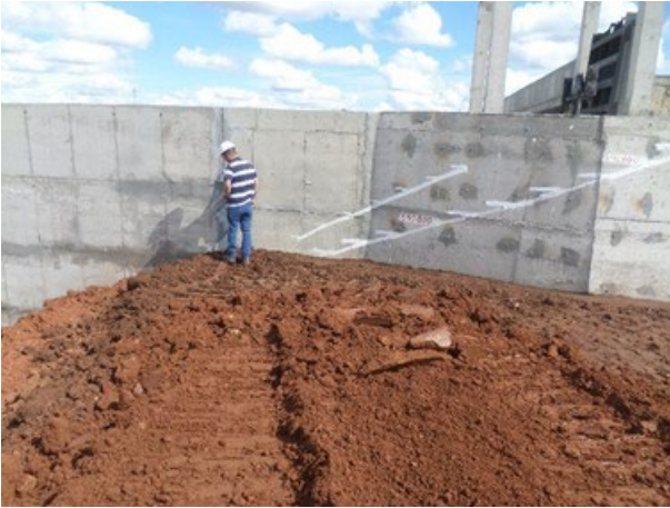
Foto 24 – Inspeção desta Supervisão do aterro de encontro com a estrutura da TUD.
