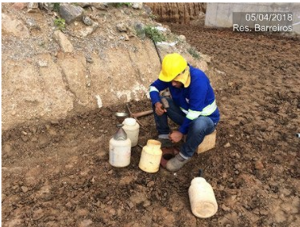
Foto 14 – Realização de ensaios de controle tecnológico do aterro.
