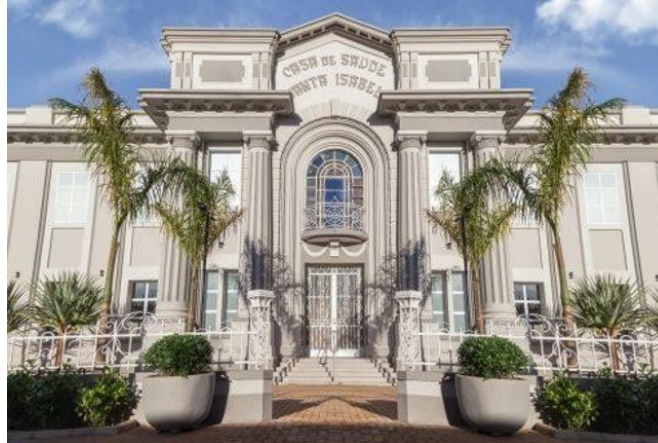
Figura 1 - Hospital Santa Casa de Araraquara.
