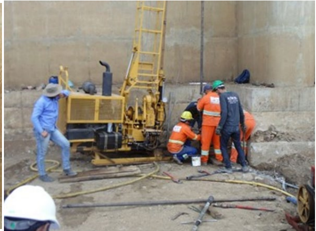
Foto 7 – Execução de injeção de calda de cimento
