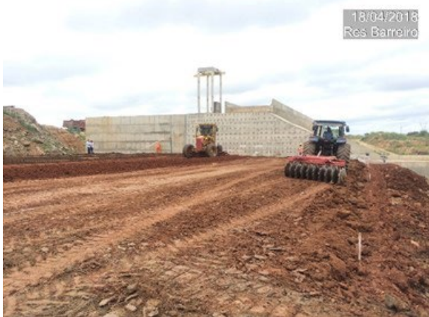
Foto 20 – Recomposição do aterro do maciço.
