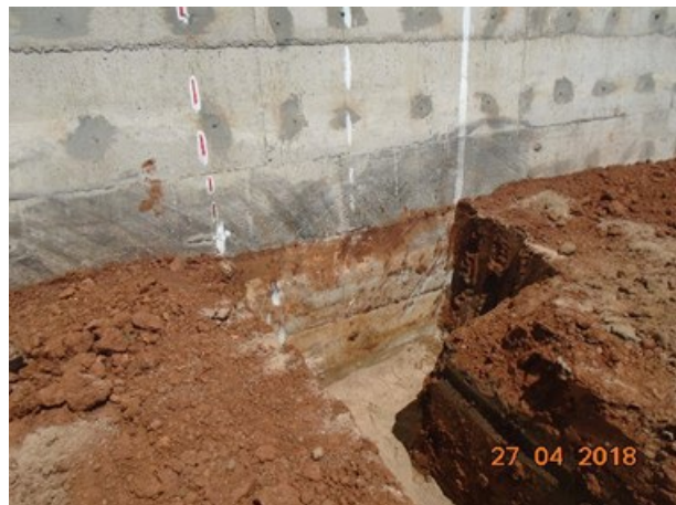
Foto 23 - Execução do filtro vertical.
