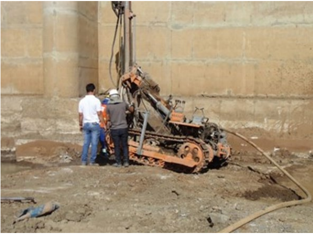
Foto 6 – Execução de injeção de calda de cimento.
