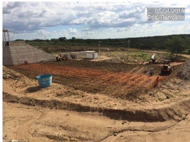
Foto 15 – Vista superior do trecho em recuperação da barragem.
