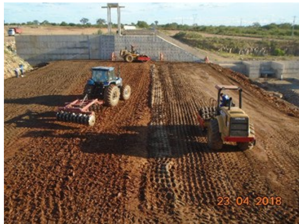
Foto 21 - Recomposição do aterro do maciço.
