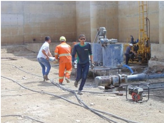
Foto 8 – Execução de injeção de calda de cimento
