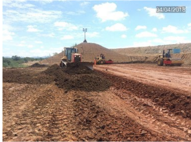
Foto 13 - Serviço de recomposição do maciço da barragem
