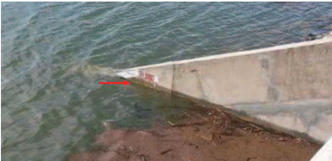
Foto 1 - Cota (540,75 m) do nível operacional de montante (03/03/2017).
