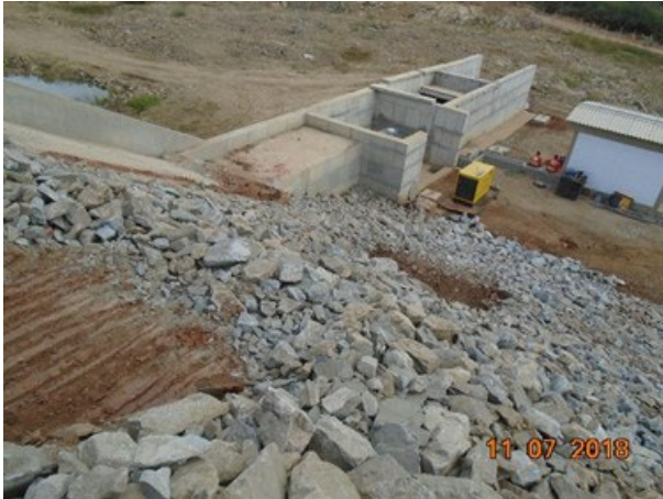
Foto 30 – Plataforma para instalação da instrumentação.
