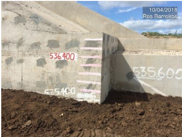
Foto 18 – Vista da evolução do aterro de recomposição do maciço da barragem.
