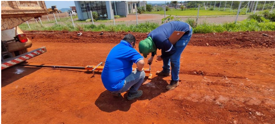
Figura 3 – Caminhão basculante com viga.
