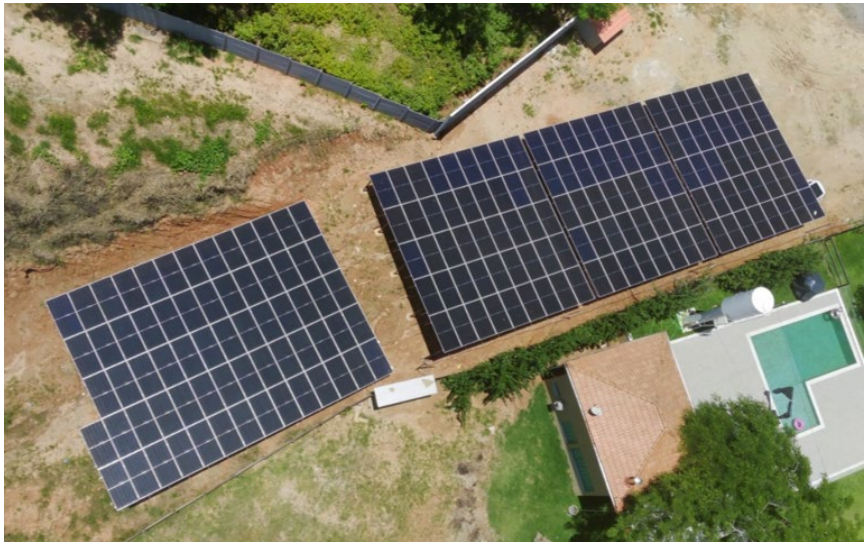
Figura 7 – Usina Fotovoltaica concluída.
