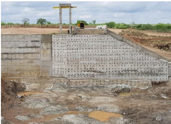
Foto 10 – Vista da fundação nas imediações de encontro com a tomada d'água.
