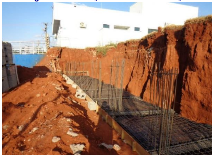
Figura 3 – Instalação da estrutura em aço.
