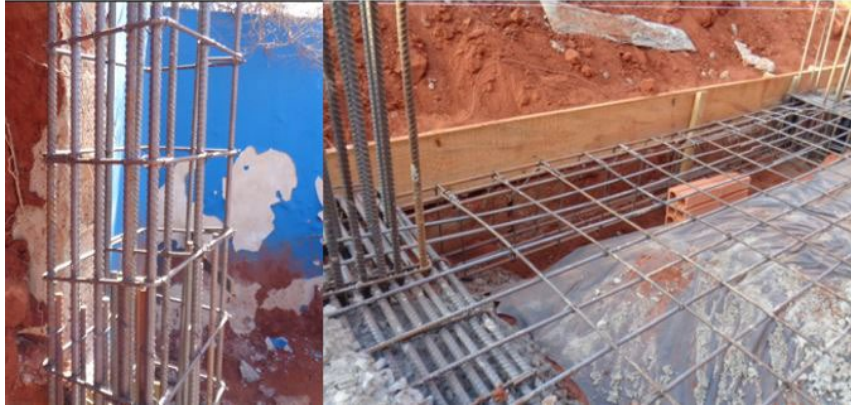
Figura 4 – Instalação aço dobrado nas especificações determinadas.
