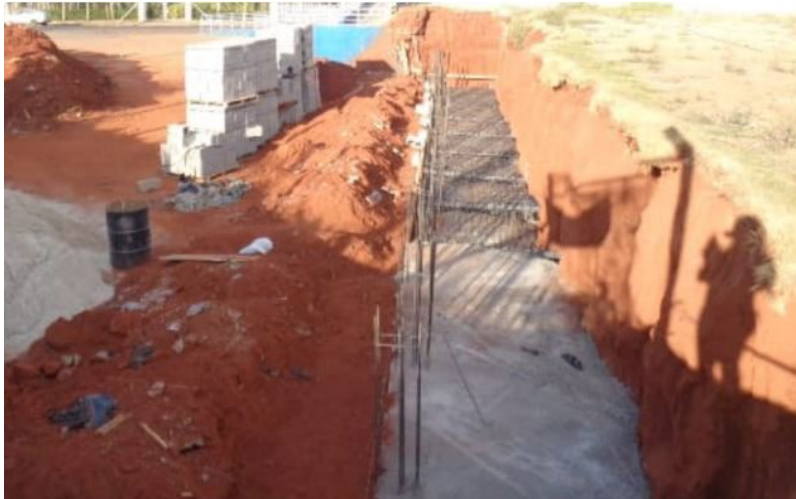
Figura 5 – Armaduras em aço já instaladas.
