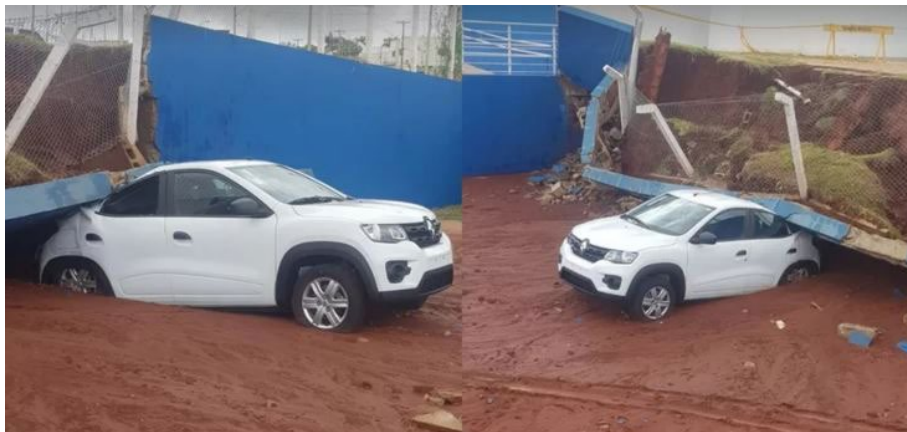
Figura 1 – Queda de muro em decorrência de chuvas.
