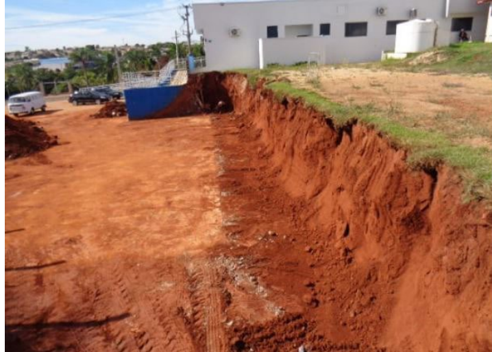
Figura 2 – Limpeza e preparo da área para a obra do muro.
