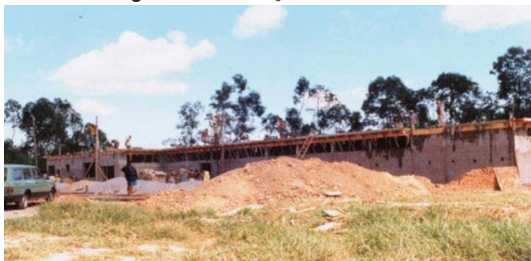
Figura 1 - Construção do atual CRS.
