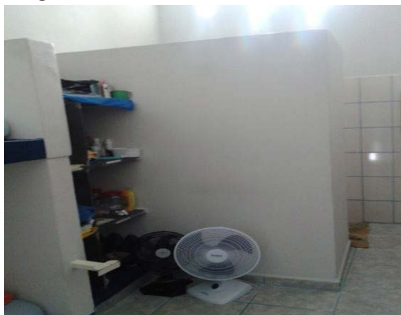
Figura 8 - Armários de alvenaria das celas.
