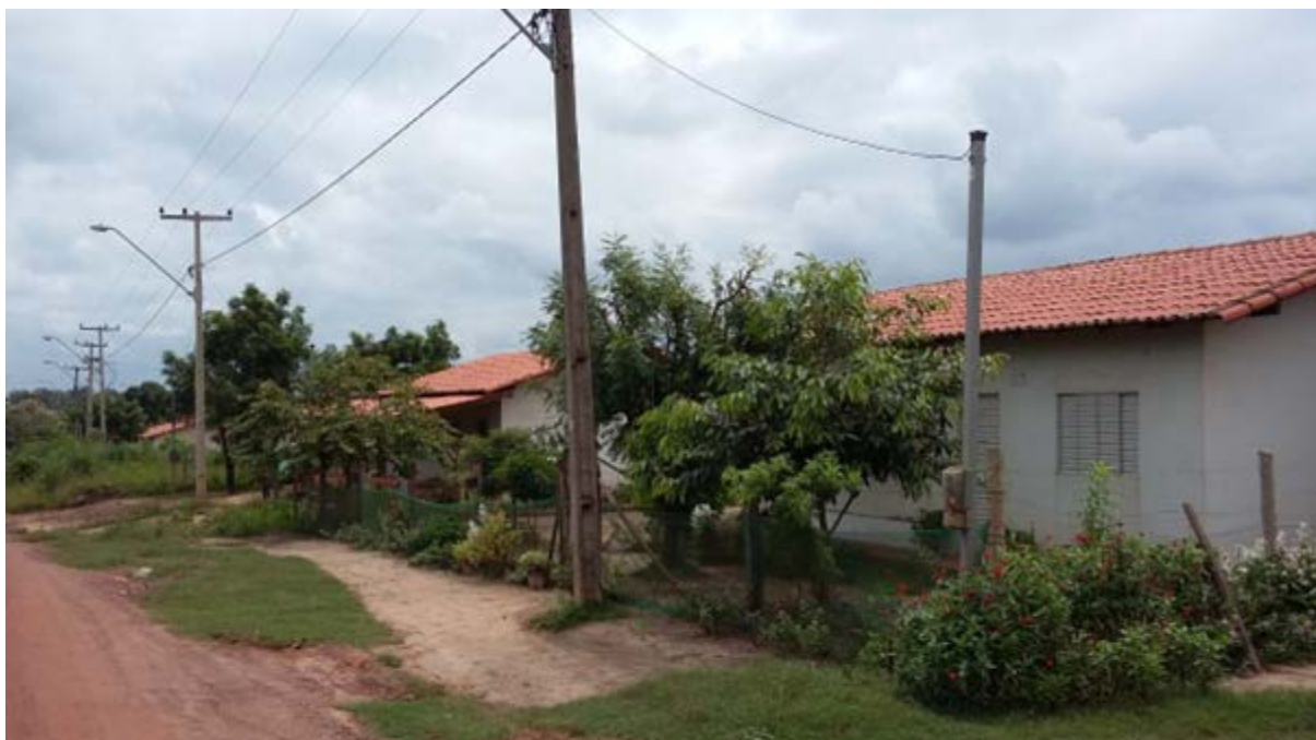
Foto 8 – Estrutura das casas doadas pela indústria de celulose.
