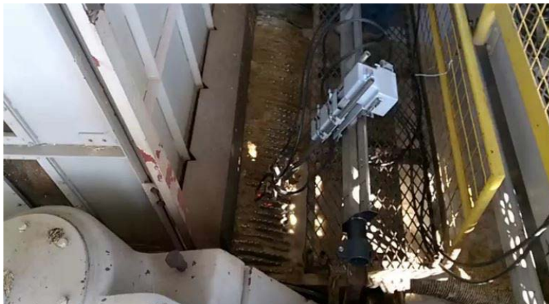
Figura 11 – Robô realizando chapisco.
