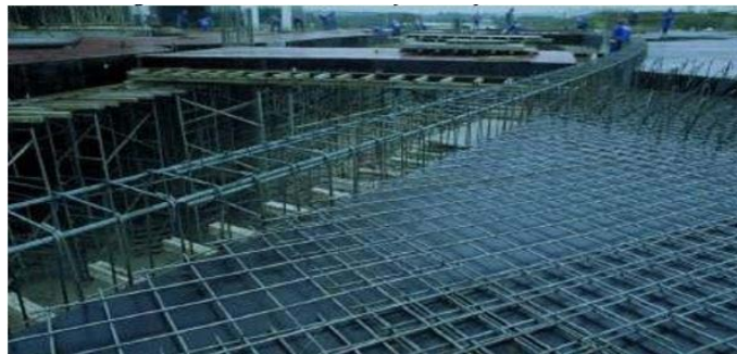
Figura 2 – Armadura da laje maciça.
