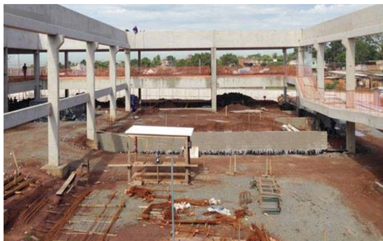
Figura 33 – Etapa construtiva racionalizada.
