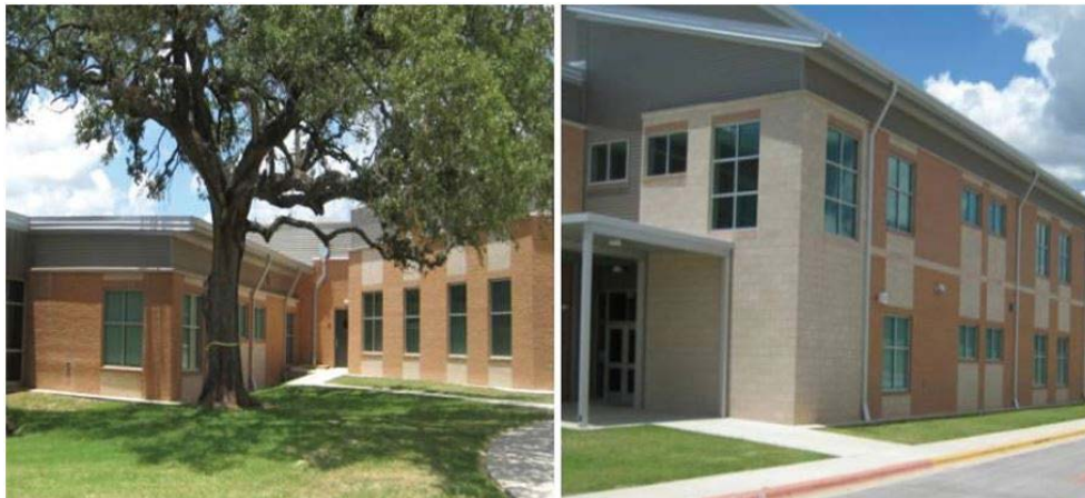
Figura 10 – Escola americana em alvenaria estrutural no Texas.
