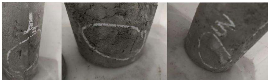
Figura 26 - Fissuração após 1 semana – CP1.
