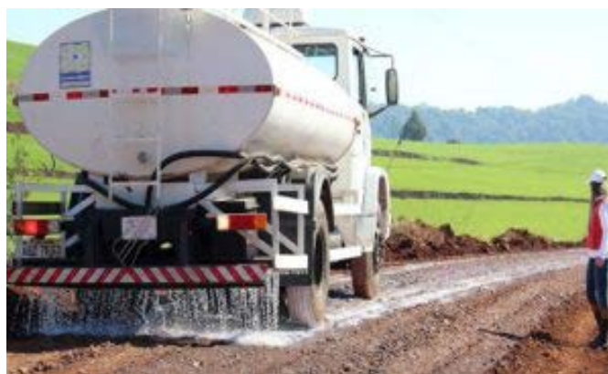
Figura 2. Exemplo de estabilização química de solos.
