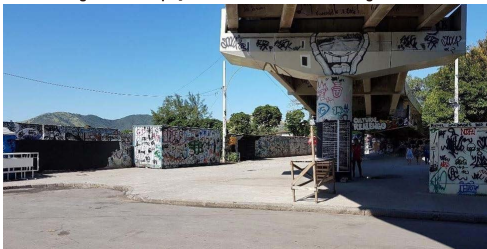
Figura 3 - O Espaço Cultural Viaduto de Realengo de dia.
