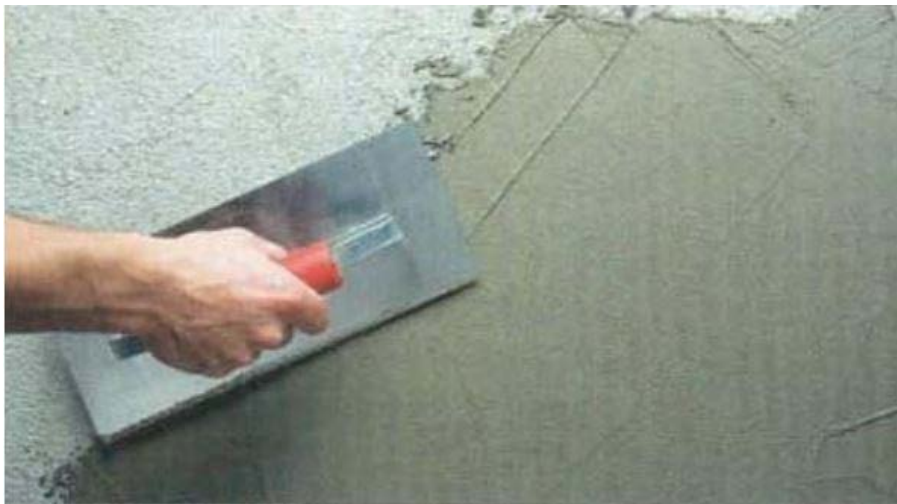
Figura 6 - Aplicação de argamassa polimérica na forma de revestimento
