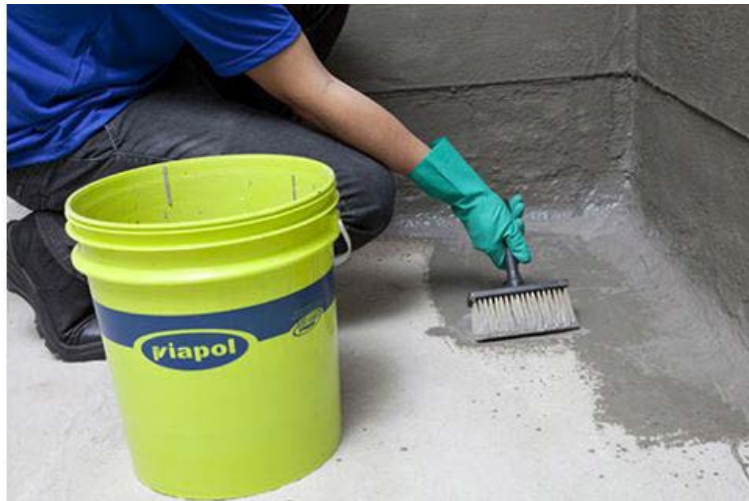
Figura 7 - Exemplo de aplicação da membrana
