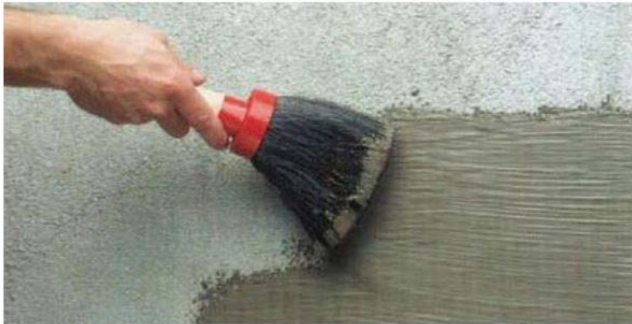
Figura 5 - Aplicação de argamassa polimérica na forma de pintura.
