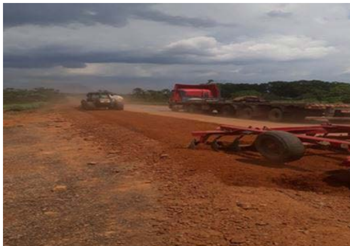
Figura 8 - Reestabilização de base degrau acostamento – Estaca 128 BR 364/RO
