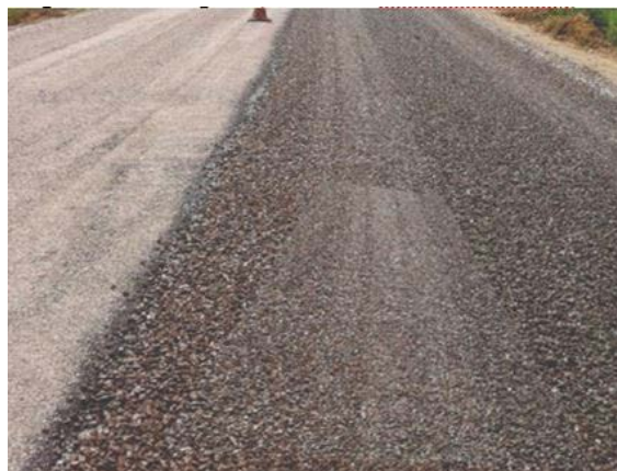
Figura 3 - Tratamento superficial duplo (camada Anti-reflexiva) estaca 1767 BR 364/RO
