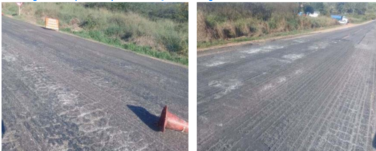
Figura 2 - Superfície após a realização da fresagem na rodovia BR 364 - Estaca 1950
