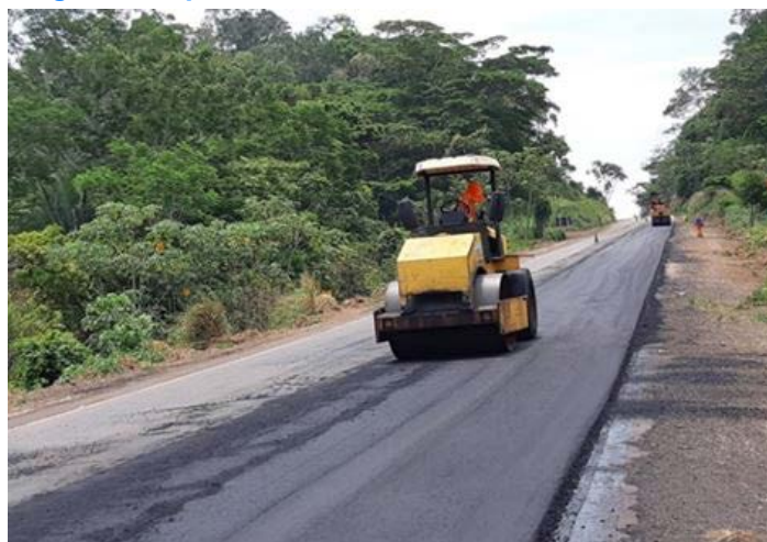
Figura 5 - Aplicação de CBUQ estaca 299 BR 364/RO
