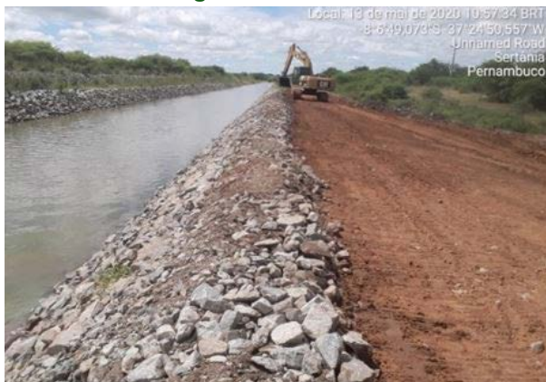
Foto 53 - Atividade de regularização do acesso e recuperação do canal enrocado no L.D hidráulico do canal, entre as estacas E-8067 e E-8078 do segmento de canal WBS 2221.
