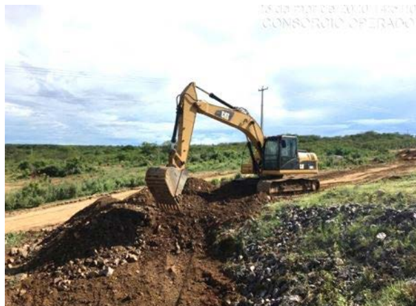
Foto 13 - Compactação de material para tratamento de erosão do maciço da estrada de O&M, no L.D hidráulico do canal, na altura da estaca E-7844 do segmento de canal WBS 2220.
