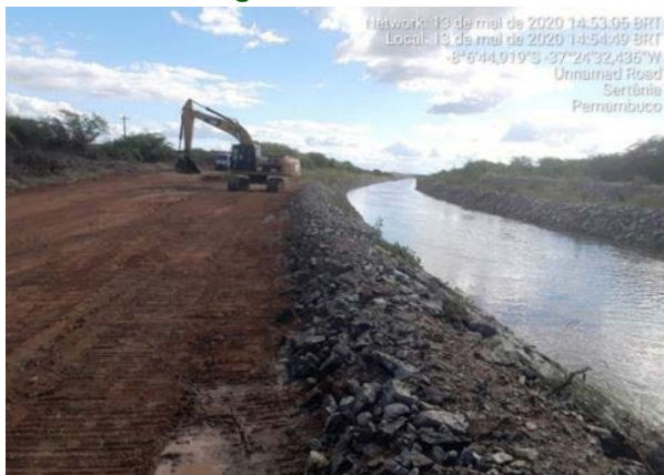
Foto 59 - Atividade de regularização do acesso e recuperação do canal enrocado no L.D hidráulico do canal, entre as estacas E-8094 e E-8098 do segmento de canal WBS 2221.
