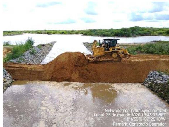
Foto 16 - Finalização da ensecadeira executada na altura da estaca E-8033 do segmento de canal WBS 2221.
