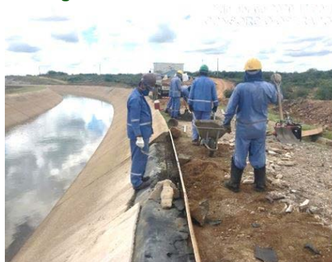
Foto 34 - Recuperação da mureta do canal no L.D hidráulico, na altura da estaca E-7856 do segmento de canal WBS 2220.
