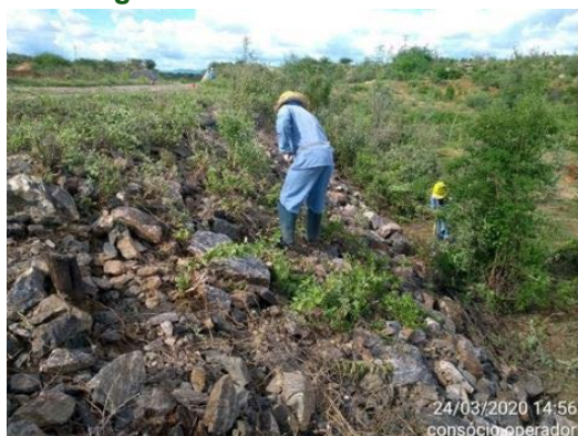
Foto 29 - Atividade de remoção da vegetação regenerada e tratamento de erosão no maciço da estrada de O&M, no lado direito hidráulico do canal, entre as estacas E-7844 e E-7865 do segmento de canal WBS 2220.
