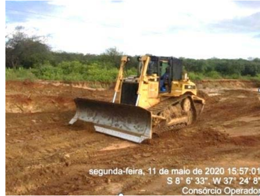
Foto 52 - Atividade de abertura de vala para drenagem de água pluvial no L.D hidráulico da estrada de serviço, entre as estacas E-8176 e E-8185 do segmento de canal WBS 2221.
