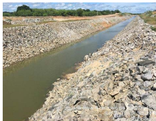
Foto 40 - Atividade de recuperação do talude enrocado do canal no L.E hidráulico, entre as estacas E-8146 e E-8149 do segmento de canal WBS 2221.
