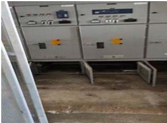
Foto 3 - Parte inferior interna do CDMT afetada pelo alagamento e TPs.
