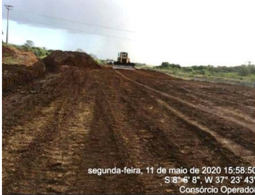
Foto 53 - Atividade de regularização do acesso e recuperação do canal enrocado no L.D hidráulico do canal, entre as estacas E-8067 e E-8078 do segmento de canal WBS 2221.
