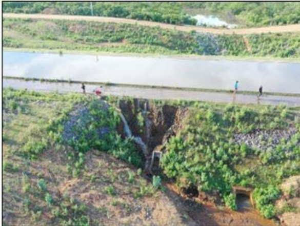
Foto 5 - Recuperação emergencial do maciço da estrada de O&M no lado direito hidráulico do canal, na altura da estaca E-7860 do segmento de canal WBS 2220.
