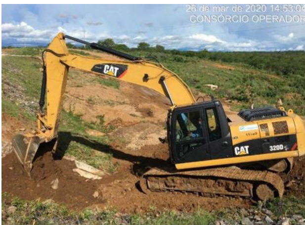
Foto 35 - Lançamento de material para tratamento de erosão do maciço da estrada de O&M, no lado direito hidráulico do canal, na altura da estaca E-7844 do segmento de canal WBS 2220.
