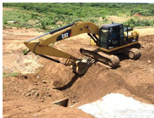
Foto 16 - Tratamento de erosão no maciço da estrada de O&M, no L.D hidráulico do canal, na altura da estaca E-7844 do segmento de canal WBS 2220.
