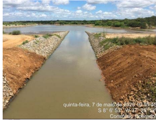
Foto 46 - Atividade de levantamento de greide das estradas de O&M e de serviço no L.D hidráulico do canal, entre as estacas E-8129 e E-8139 do segmento de canal WBS 2221.
