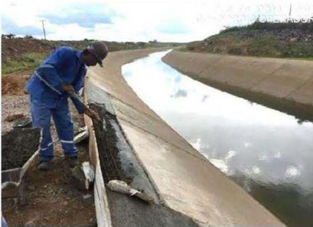
Foto 37 - Recuperação da canaleta de drenagem de águas pluviais no L.D hidráulico do canal, entre as estacas E-7856 e E-7839 do segmento de canal WBS 2220.
