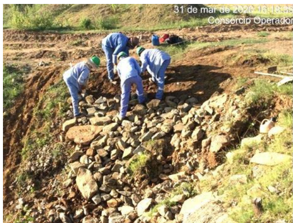
Foto 31 - Recuperação da mureta do canal no L.D hidráulico, na altura da estaca E-7856 do segmento de canal WBS 2220.
