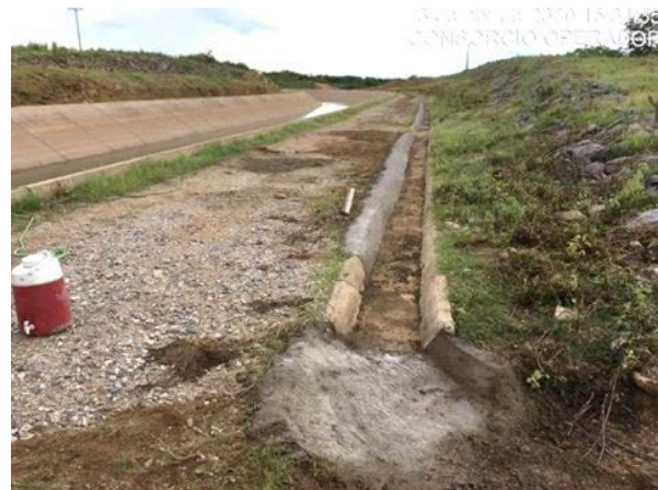
Foto 40 - Recuperação da canaleta de drenagem de águas pluviais no L.D hidráulico do canal, entre as estacas E-7856 e E-7839 do segmento de canal WBS 2220.
