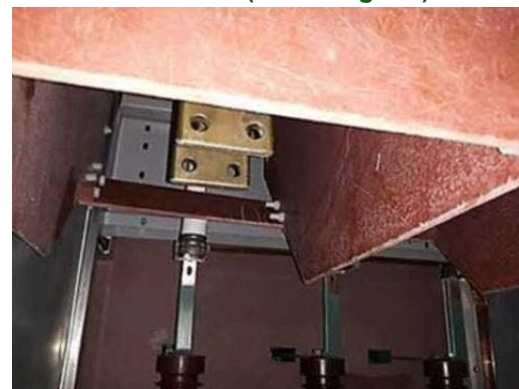
Foto 38 - Realizado a conexão dos TCs do cubículo 4 (entrada geral)
