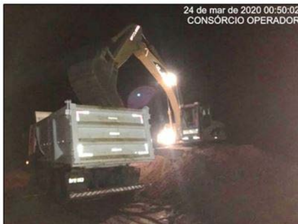
Foto 12 - Recuperação emergencial do maciço da estrada de O&M no lado direito hidráulico do canal, na altura da estaca E-7860 do segmento de canal WBS 2220.
