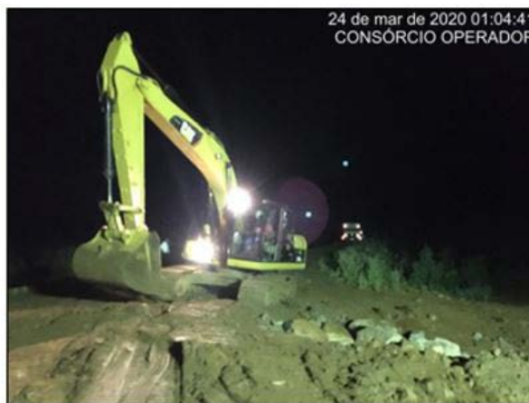
Foto 16 - Recuperação emergencial do maciço da estrada de O&M no lado direito hidráulico do canal, na altura da estaca E-7860 do segmento de canal WBS 2220.
