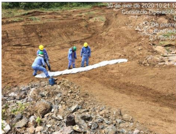
Foto 26 - Tratamento de erosão no maciço da estrada de O&M, no L.E hidráulico do canal, na altura da estaca E-7862 do segmento de canal WBS 2220.
