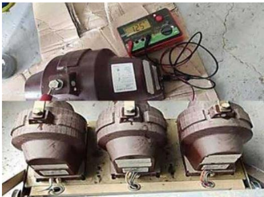
Foto 11 - Condição inicial dos cubículos dos disjuntores
