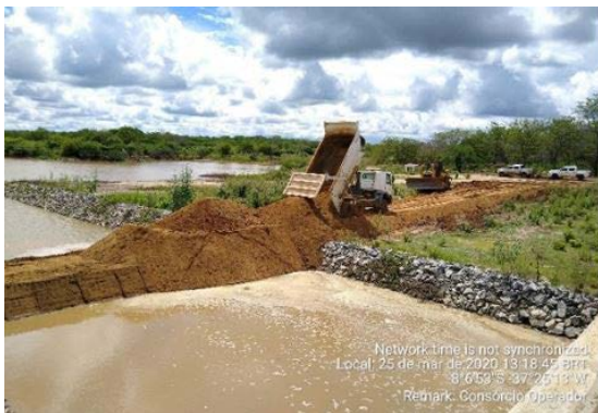
Foto 13 - Extração de material argilo-arenoso para execução de ensecadeira na altura da estaca E-8033 do segmento de canal WBS 2221.
