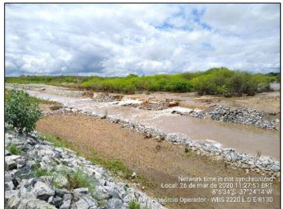
Foto 6 - Ponto de transbordamento das águas do Rio Moxotó para o interior do canal do PISF no lado direito hidráulico, na altura da estaca E-8130 do segmento de canal WBS 2221
