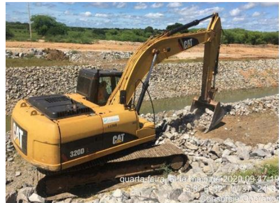
Foto 36 - Atividade de recuperação do talude enrocado do canal no L.E hidráulico, entre as estacas E-8139 e E-8140 do segmento de canal WBS 2221.
