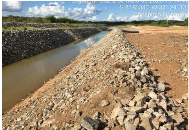
Foto 10 - Atividade de regularização do acesso e recuperação do canal enrocado no L.D hidráulico do canal, entre as estacas E-8043 e E-8045 do segmento de canal WBS 2221.
