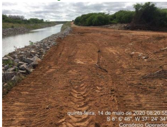
Foto 60 - Atividade de regularização do acesso e recuperação do canal enrocado no L.D hidráulico do canal, entre as estacas E-8094 e E-8098 do segmento de canal WBS 2221.
