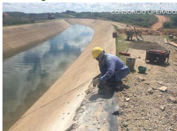
Foto 34 - Recuperação da mureta do canal no L.D hidráulico, na altura da estaca E-7856 do segmento de canal WBS 2220.
