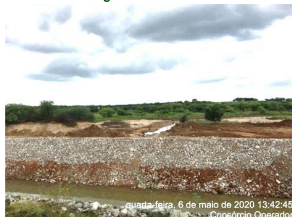
Foto 24 - Atividade de regularização do acesso e recuperação do canal enrocado no L.D hidráulico do canal, entre as estacas E-8043 e E-8045 do segmento de canal WBS 2221.
