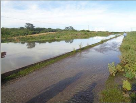
Foto 3 - Ponto de transbordamento do canal para o maciço da estrada de O&M no lado direito hidráulico do canal, na altura da estaca E-7800 do segmento de canal WBS 2220.
