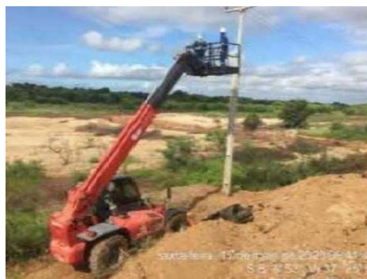
Foto 6 - Nova estrutura implantada (foi necessária uma segunda estrutura para sobrepujar o vão aberto no rompimento do canal).
