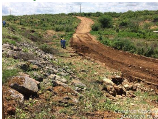
Foto 9 - Atividade de remoção da vegetação regenerada e tratamento de erosão no maciço da estrada de O&M, no lado direito hidráulico do canal, entre as estacas E-7844 e E-7865 do segmento de canal WBS 2220.
