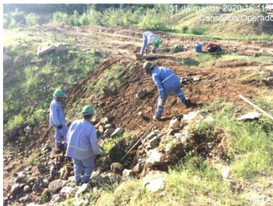
Foto 28 - Tratamento de erosão no maciço da estrada de O&M, no L.E hidráulico do canal, na altura da estaca E-7862 do segmento de canal WBS 2220.
