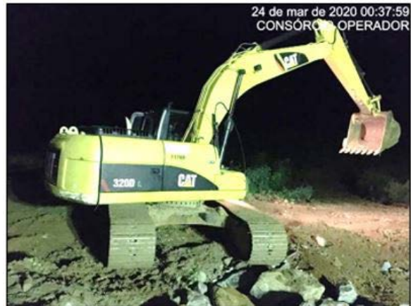
Foto 10 - Recuperação emergencial do maciço da estrada de O&M no lado direito hidráulico do canal, na altura da estaca E-7860 do segmento de canal WBS 2220.
