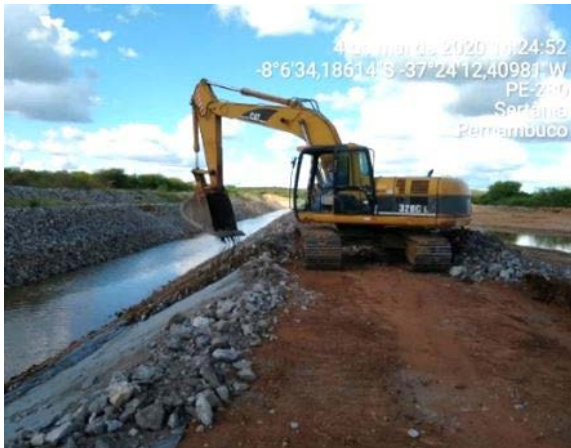
Foto 9 - Atividade de regularização do acesso e recuperação do canal enrocado no L.D hidráulico do canal, entre as estacas E-8043 e E-8045 do segmento de canal WBS 2221.
