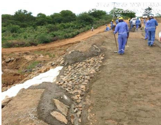
Foto 27 - Tratamento de erosão no maciço da estrada de O&M, no L.E hidráulico do canal, na altura da estaca E-7862 do segmento de canal WBS 2220.
