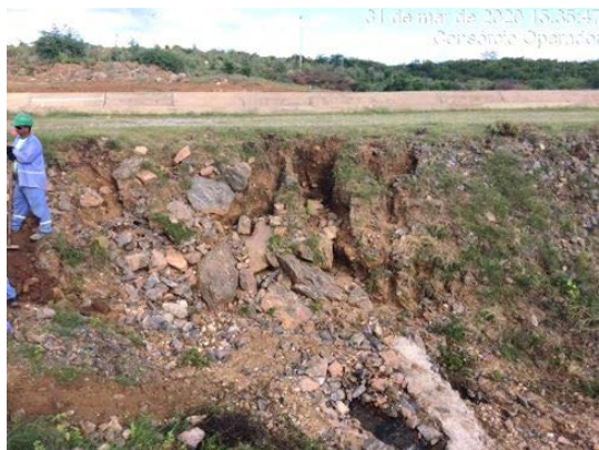
Foto 27 - Tratamento de erosão no maciço da estrada de O&M, no L.E hidráulico do canal, na altura da estaca E-7862 do segmento de canal WBS 2220.
