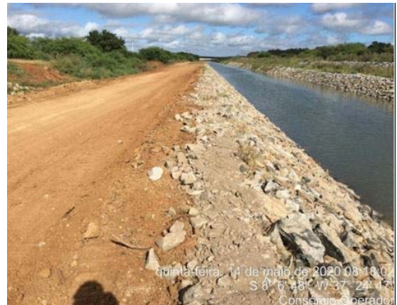
Foto 58 - Atividade de regularização do acesso e recuperação do canal enrocado no L.D hidráulico do canal, entre as estacas E-8094 e E-8098 do segmento de canal WBS 2221.
