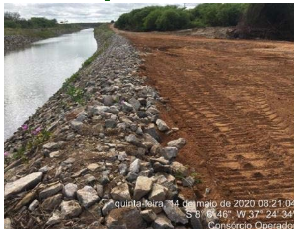
Foto 59 - Atividade de regularização do acesso e recuperação do canal enrocado no L.D hidráulico do canal, entre as estacas E-8094 e E-8098 do segmento de canal WBS 2221.
