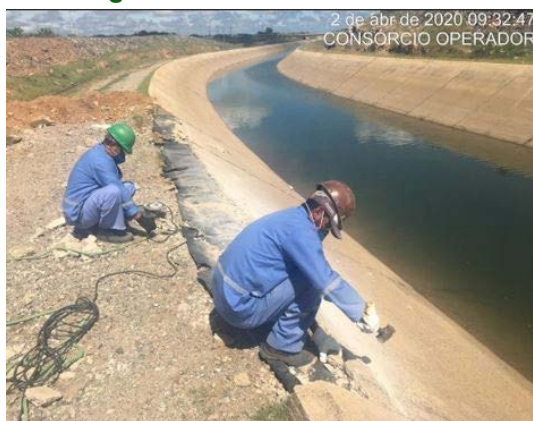
Foto 33 - Recuperação da mureta do canal no L.D hidráulico, na altura da estaca E-7856 do segmento de canal WBS 2220.
