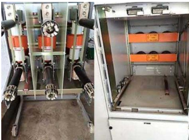
Foto 13 - Equipamentos e ferramental mobilizados para a recuperação dos sistemas na EBV-5.
