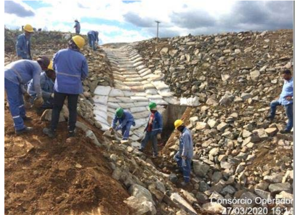
Foto 20 - Tratamento de erosão no maciço da estrada de O&M, no L.D hidráulico do canal, na altura da estaca E-7860 do segmento de canal WBS 2220.
