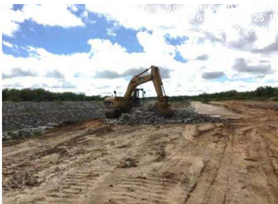
Foto 27 - Atividade de recuperação do enrocamento do talude no L.D hidráulico do canal, na altura da estaca E-8137 do segmento de canal WBS 2221.
