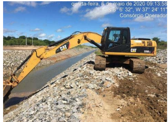
Foto 34 - Atividade de recuperação do talude enrocado do canal no L.E hidráulico, na altura da estaca E-8135 do segmento de canal WBS 2221.
