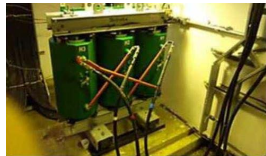
Após limpeza das mufas, colocação no lugar das mufas trato auxiliar 1
