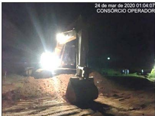
Foto 15 - Recuperação emergencial do maciço da estrada de O&M no lado direito hidráulico do canal, na altura da estaca E-7860 do segmento de canal WBS 2220.
