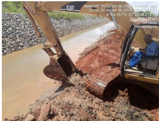
Foto 15 - Atividade de regularização do acesso e recuperação do canal enrocado no L.D hidráulico do canal, entre as estacas E-8043 e E-8045 do segmento de canal WBS 2221.
