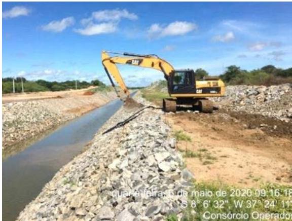
Foto 35 - Atividade de recuperação do talude enrocado do canal no L.E hidráulico, entre as estacas E-8139 e E-8140 do segmento de canal WBS 2221.
