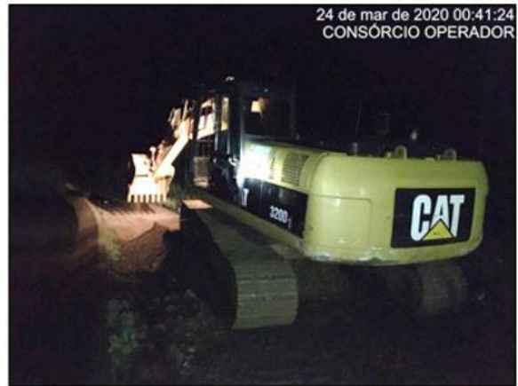
Foto 12 - Recuperação emergencial do maciço da estrada de O&M no lado direito hidráulico do canal, na altura da estaca E-7860 do segmento de canal WBS 2220.
