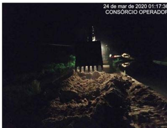
Foto 18 - Recuperação emergencial do maciço da estrada de O&M no lado direito hidráulico do canal, na altura da estaca E-7860 do segmento de canal WBS 2220.
