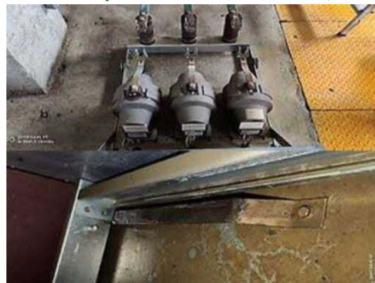
Foto 6 - Condição em que se encontrava os carros suporte dos TPs de barra 6,9KV
