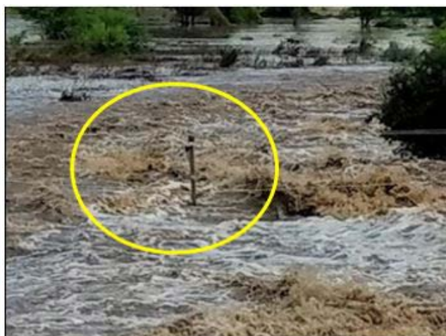
Foto 10 - Estrutura da LD 13,8 kV danificada pela ação das chuvas
