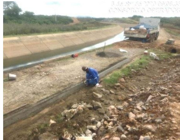
Foto 40 - Recuperação da canaleta de drenagem de águas pluviais no L.D hidráulico do canal, entre as estacas E-7856 e E-7839 do segmento de canal WBS 2220.
