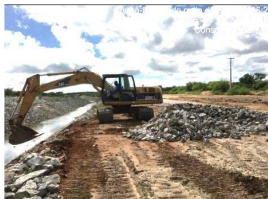
Foto 28 - Atividade de recuperação do enrocamento do talude no L.D hidráulico do canal, na altura da estaca E-8137 do segmento de canal WBS 2221.
