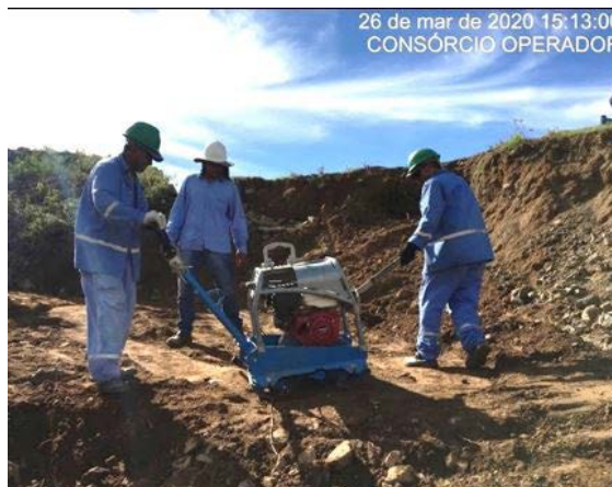
Foto 14 - Tratamento de erosão do maciço da estrada de O&M, no L.D hidráulico do canal, na altura da estaca E-7844 do segmento de canal WBS 2220.
