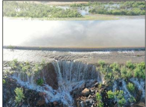
Foto 6 - Recuperação emergencial do maciço da estrada de O&M no lado direito hidráulico do canal, na altura da estaca E-7860 do segmento de canal WBS 2220.
