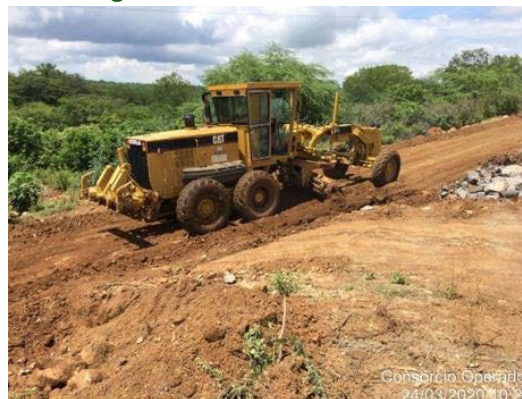
Foto 10 - Atividade de remoção da vegetação regenerada e tratamento de erosão no maciço da estrada de O&M, no L.D hidráulico do canal, entre as estacas E-7844 e E-7865 do segmento de canal WBS 2220.
