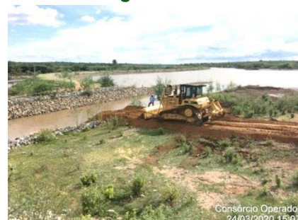
Foto 8 - Execução de ensecadeira na altura da estaca E-8033 do segmento de canal WBS 2221.
