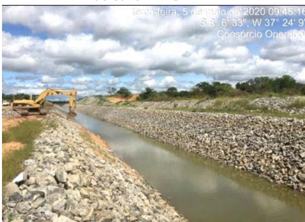
Foto 29 - Atividade de recuperação do enrocamento do talude no L.D hidráulico do canal, na altura da estaca E-8137 do segmento de canal WBS 2221.
