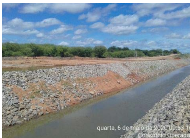
Foto 30 - Atividade de recuperação do enrocamento do talude no L.D hidráulico do canal, na altura da estaca E-8137 do segmento de canal WBS 2221.
