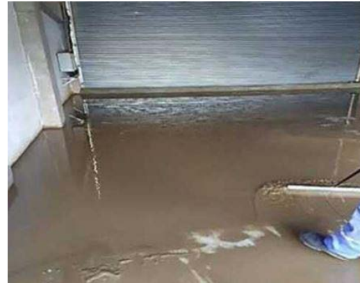
Foto 6 - Condição em que se encontrava os carros suporte dos TPs de barra 6,9KV
