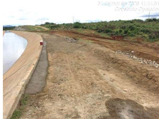
Foto 22 - Abertura da vala para direcionamento das águas pluviais no L.D hidráulico do canal, na altura da estaca E-7860 do segmento de canal WBS 2220.
