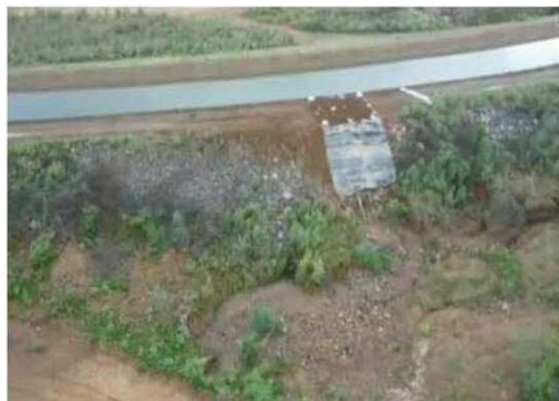
Foto 8 - Atividade de remoção da vegetação regenerada e tratamento de erosão no maciço da estrada de O&M, no lado direito hidráulico do canal, entre as estacas E-7844 e E-7865 do segmento de canal WBS 2220.
