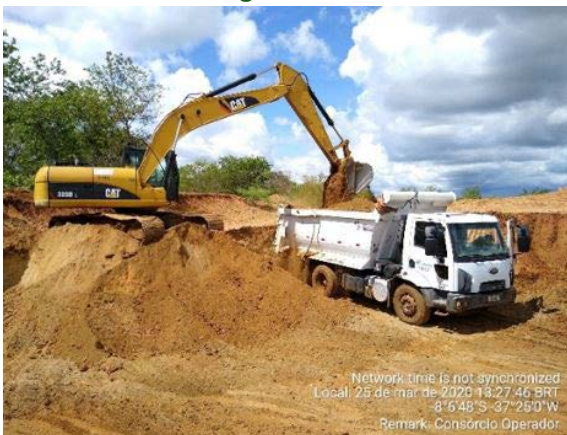
Foto 15 - Execução de ensecadeira na altura da estaca E-8033 do segmento de canal WBS 2221.
