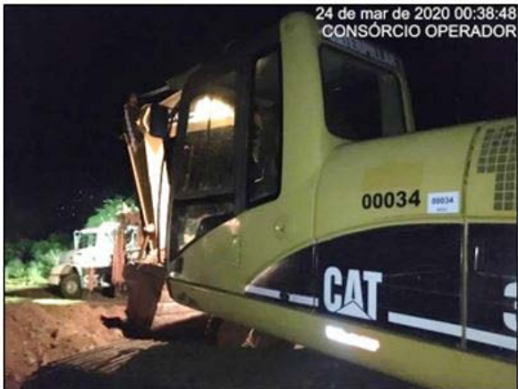
Foto 11 - Recuperação emergencial do maciço da estrada de O&M no lado direito hidráulico do canal, na altura da estaca E-7860 do segmento de canal WBS 2220.
