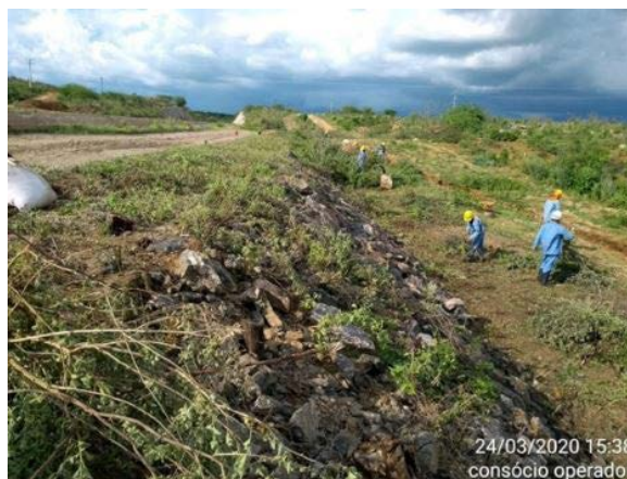
Foto 10 - Atividade de remoção da vegetação regenerada e tratamento de erosão no maciço da estrada de O&M, no L.D hidráulico do canal, entre as estacas E-7844 e E-7865 do segmento de canal WBS 2220.
