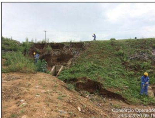
Foto 23 - Atividade de remoção da vegetação regenerada e tratamento de erosão no maciço da estrada de O&M, no lado direito hidráulico do canal, entre as estacas E-7844 e E-7865 do segmento de canal WBS 2220.
