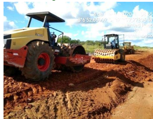
Foto 24 - Atividade de regularização do acesso e recuperação do canal enrocado no L.D hidráulico do canal, entre as estacas E-8043 e E-8045 do segmento de canal WBS 2221.
