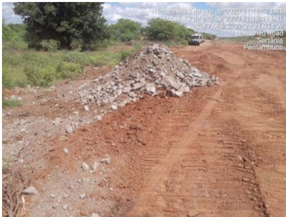
Foto 57 - Atividade de regularização do acesso e recuperação do canal enrocado no L.D hidráulico do canal, entre as estacas E-8094 e E-8098 do segmento de canal WBS 2221.
