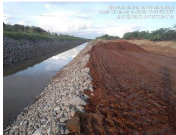
Foto 18 - Atividade de regularização do acesso e recuperação do canal enrocado no L.D hidráulico do canal, entre as estacas E-8043 e E-8045 do segmento de canal WBS 2221.
