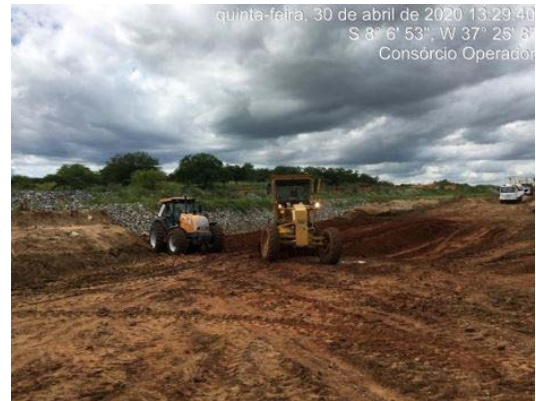
Foto 16 - Atividade de regularização do acesso e recuperação do canal enrocado no L.D hidráulico do canal, entre as estacas E-8043 e E-8045 do segmento de canal WBS 2221.
