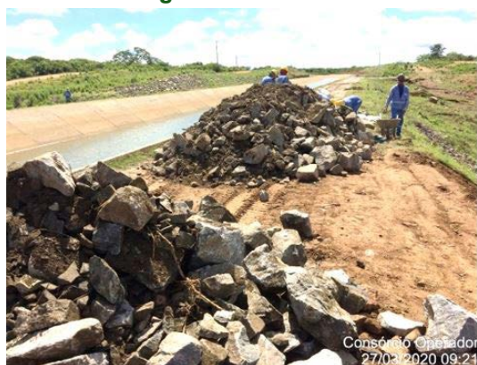
Foto 15 - Material rochoso para complementação do enrocamento do maciço da estrada de O&M, no L.D hidráulico do canal, na altura da estaca E-7844 do segmento de canal WBS 2220.
