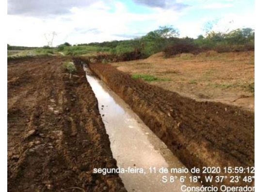
Foto 54 - Atividade de regularização do acesso e recuperação do canal enrocado no L.D hidráulico do canal, entre as estacas E-8067 e E-8078 do segmento de canal WBS 2221.
