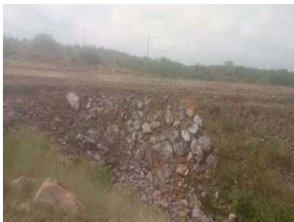
Foto 32 - Recuperação da mureta do canal no L.D hidráulico, na altura da estaca E-7856 do segmento de canal WBS 2220.
