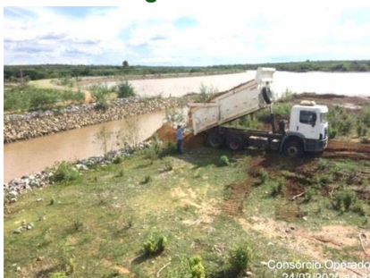
Foto 7 - Execução de ensecadeira na altura da estaca E-8033 do segmento de canal WBS 2221.
