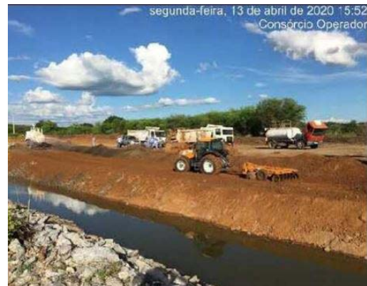
Foto 6 - Aplicação de manta bidim para recuperação do enrocamento do canal no L.D hidráulico, entre as estacas E-8131 e E-8135 do segmento de canal WBS 2221.
