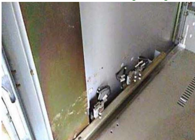
Foto 14 - Implantado estufa com lâmpadas, para auxiliar na secagem dos equipamentos.
