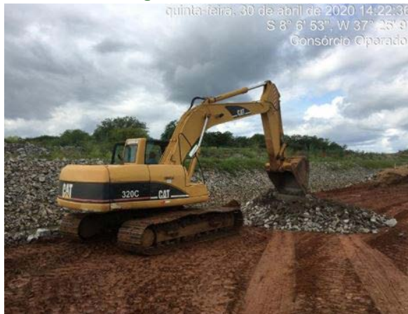
Foto 17 - Atividade de regularização do acesso e recuperação do canal enrocado no L.D hidráulico do canal, entre as estacas E-8043 e E-8045 do segmento de canal WBS 2221.
