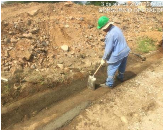
Foto 39 - Recuperação da canaleta de drenagem de águas pluviais no L.D hidráulico do canal, entre as estacas E-7856 e E-7839 do segmento de canal WBS 2220.
