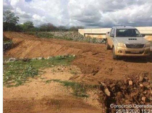
Foto 4 -Atividade de recuperação do maciço do canal lado direito hidráulico, entre as estacas E-8131 e E-8135 do segmento de canal WBS 2221.
