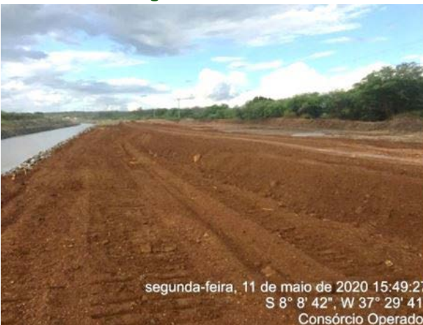
Foto 47 - Atividade de levantamento de greide das estradas de O&M e de serviço no L.D hidráulico do canal, entre as estacas E-8129 e E-8139 do segmento de canal WBS 2221.
