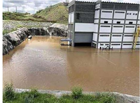
Foto 4 - As águas atingiram 1m acima do piso atingindo os painéis de média tensão posicionados no térreo.
