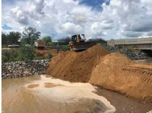
Foto 3 - Atividade de recuperação do maciço do canal lado direito hidráulico, entre as estacas E-8131 e E-8135 do segmento de canal WBS 2221.
