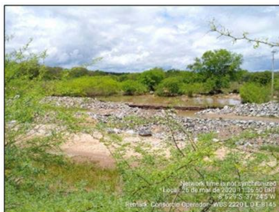
Foto 8- Ponto de transbordamento das águas do Rio Moxotó para o interior do canal do PISF no lado direito hidráulico, na altura da estaca E-8145 do segmento de canal WBS 2221.
