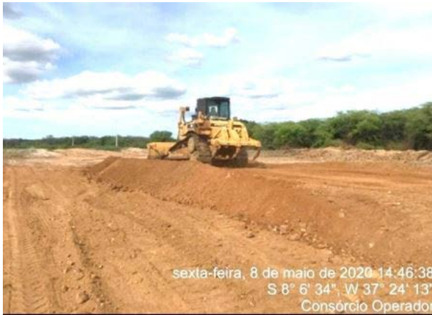
Foto 47 - Atividade de levantamento de greide das estradas de O&M e de serviço no L.D hidráulico do canal, entre as estacas E-8129 e E-8139 do segmento de canal WBS 2221.
