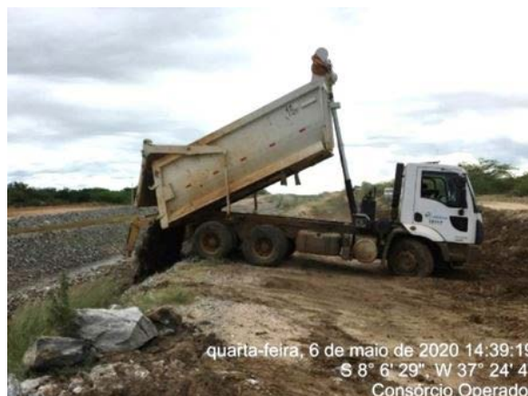
Foto 42 - Atividade de recuperação do talude enrocado do canal no L.E hidráulico, entre as estacas E-8146 e E-8149 do segmento de canal WBS 2221.
