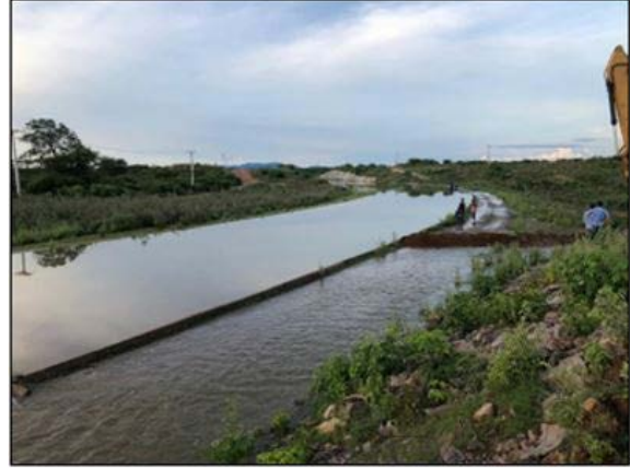
Foto 4 - Ponto de transbordamento do canal para o maciço da estrada de O&M em ambos os lados do canal, na altura da estaca E-8036 do segmento de canal WBS 2220.
