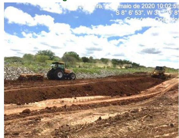
Foto 18 - Atividade de regularização do acesso e recuperação do canal enrocado no L.D hidráulico do canal, entre as estacas E-8043 e E-8045 do segmento de canal WBS 2221.
