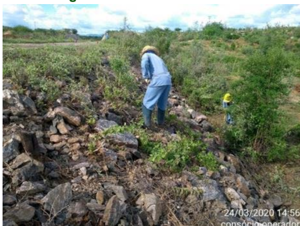
Foto 9 - Atividade de remoção da vegetação regenerada e tratamento de erosão no maciço da estrada de O&M, no lado direito hidráulico do canal, entre as estacas E-7844 e E-7865 do segmento de canal WBS 2220.
