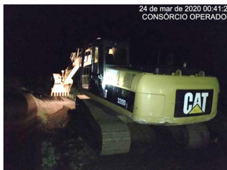
Foto 4 - Recuperação emergencial do maciço da estrada de O&M no lado direito hidráulico do canal, na altura da estaca E-7860 do segmento de canal WBS 2220.
