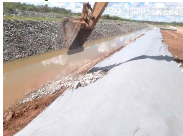
Foto 6 - Aplicação de manta bidim para recuperação do enrocamento do canal no L.D hidráulico, entre as estacas E-8131 e E-8135 do segmento de canal WBS 2221.
