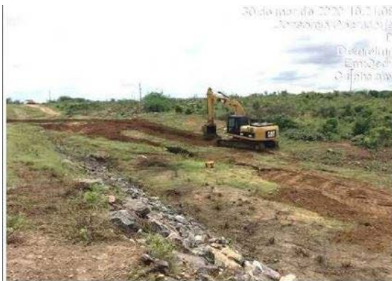
Foto 21 - Abertura da vala para direcionamento das águas pluviais no L.D hidráulico do canal, na altura da estaca E-7860 do segmento de canal WBS 2220.
