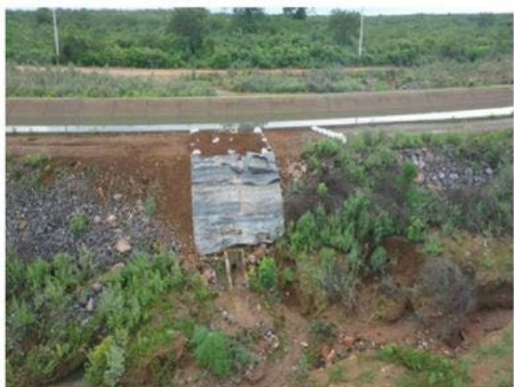
Foto 29 - Atividade de remoção da vegetação regenerada e tratamento de erosão no maciço da estrada de O&M, no lado direito hidráulico do canal, entre as estacas E-7844 e E-7865 do segmento de canal WBS 2220.
