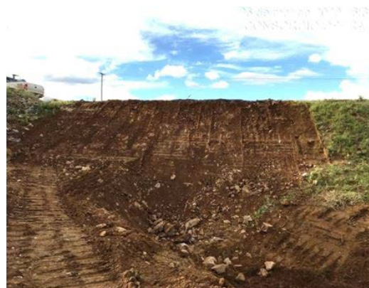
Foto 16 - Tratamento de erosão no maciço da estrada de O&M, no L.D hidráulico do canal, na altura da estaca E-7844 do segmento de canal WBS 2220.
