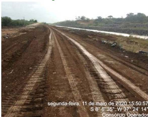
Foto 48 - Atividade de levantamento de greide das estradas de O&M e de serviço no L.D hidráulico do canal, entre as estacas E-8129 e E-8139 do segmento de canal WBS 2221.
