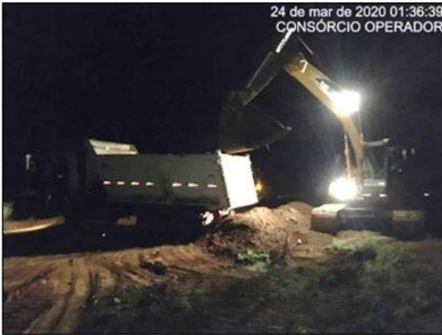
Foto 21 - Recuperação emergencial do maciço da estrada de O&M no L.D hidráulico do canal, na altura da estaca E-7860 do segmento de canal WBS 2220.
