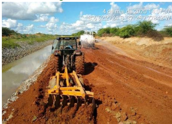
Foto 23 - Atividade de regularização do acesso e recuperação do canal enrocado no L.D hidráulico do canal, entre as estacas E-8043 e E-8045 do segmento de canal WBS 2221.
