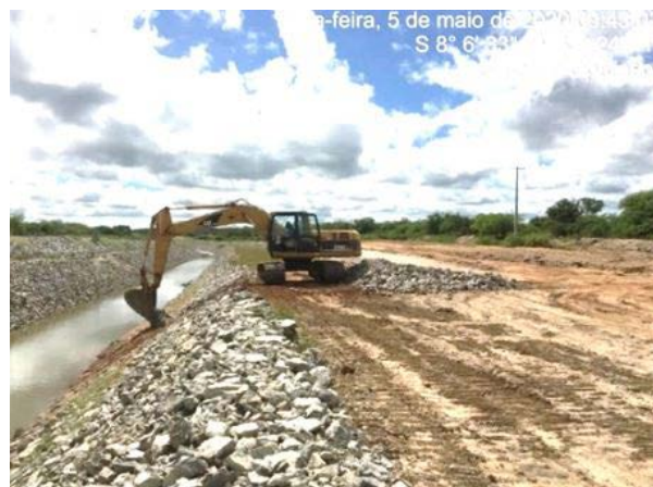
Foto 30 - Atividade de recuperação do enrocamento do talude no L.D hidráulico do canal, na altura da estaca E-8137 do segmento de canal WBS 2221.
