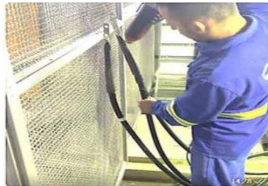
Realizado limpeza e secagem das mufas
