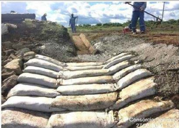
Foto 19 - Escavação para reparo da mureta do canal no L.D hidráulico, na altura da estaca E-7860 do segmento de canal WBS 2220.
