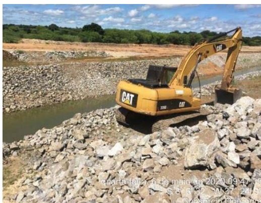
Foto 39 - Atividade de recuperação do talude enrocado do canal no L.E hidráulico, entre as estacas E-8146 e E-8149 do segmento de canal WBS 2221.
