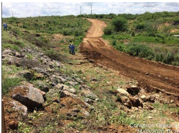
Foto 27 - Atividade de remoção da vegetação regenerada e tratamento de erosão no maciço da estrada de O&M, no lado direito hidráulico do canal, entre as estacas E-7844 e E-7865 do segmento de canal WBS 2220.
