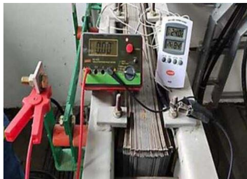
Foto 10 - Condições das vagetas inferiores do CDMT, onde estão posicionados os TPs de proteção.
