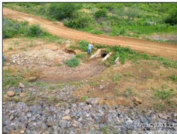
Foto 30 - Atividade de remoção da vegetação regenerada e tratamento de erosão no maciço da estrada de O&M, no lado direito hidráulico do canal, entre as estacas E-7844 e E-7865 do segmento de canal WBS 2220.
