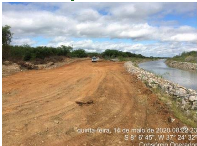
Foto 60 - Atividade de regularização do acesso e recuperação do canal enrocado no L.D hidráulico do canal, entre as estacas E-8094 e E-8098 do segmento de canal WBS 2221.
