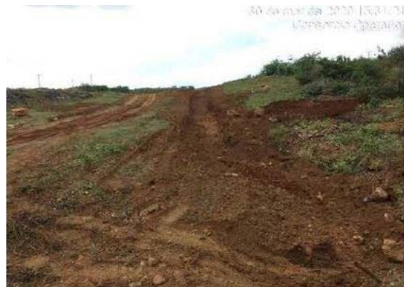
Foto 22 - Abertura da vala para direcionamento das águas pluviais no L.D hidráulico do canal, na altura da estaca E-7860 do segmento de canal WBS 2220.
