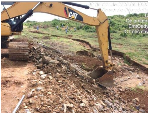
Foto 25 - Tratamento de erosão no maciço da estrada de O&M, no L.E hidráulico do canal, na altura da estaca E-7862 do segmento de canal WBS 2220.
