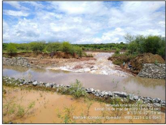
Foto 4 - Ponto de transbordamento das águas do Rio Moxotó para o interior do canal PISF no lado direito hidráulico, na altura da estaca E-8102 do segmento de canal WBS 2221
