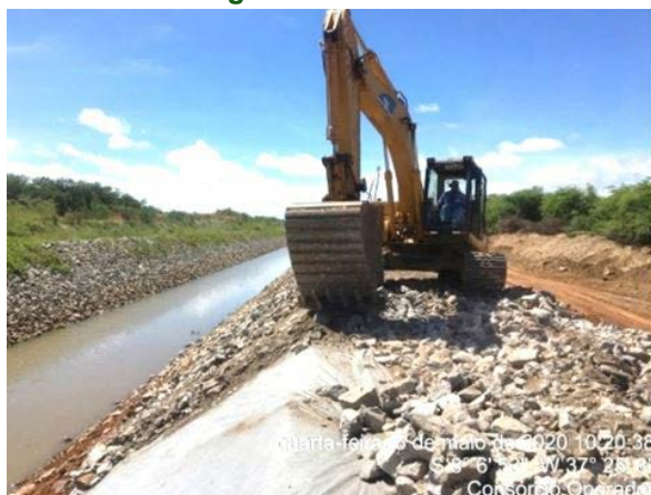
Foto 23 - Atividade de regularização do acesso e recuperação do canal enrocado no L.D hidráulico do canal, entre as estacas E-8043 e E-8045 do segmento de canal WBS 2221.
