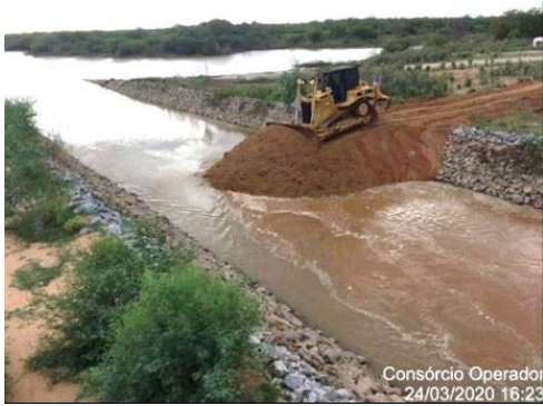
Foto 11 - Execução de ensecadeira na altura da estaca E-8033 do segmento de canal WBS 2221.
