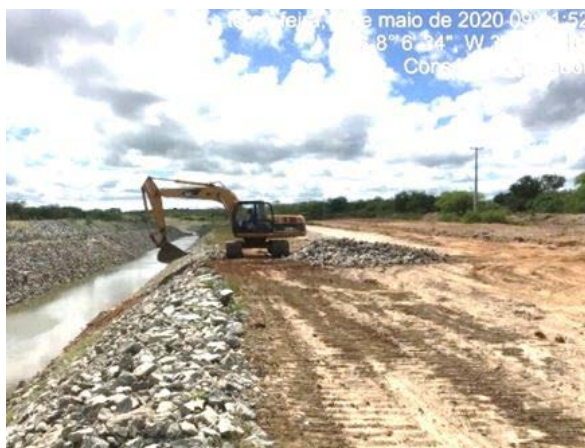
Foto 29 - Atividade de recuperação do enrocamento do talude no L.D hidráulico do canal, na altura da estaca E-8137 do segmento de canal WBS 2221.
