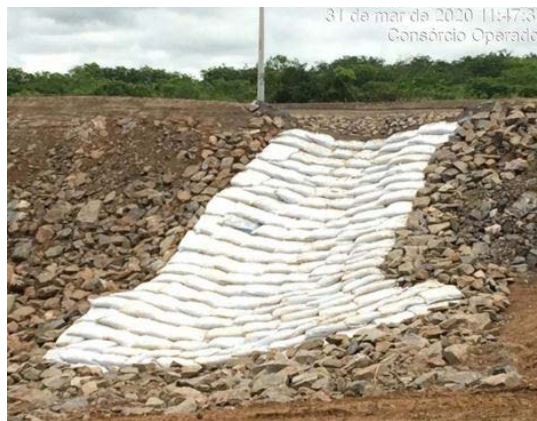
Foto 28 - Tratamento de erosão no maciço da estrada de O&M, no L.E hidráulico do canal, na altura da estaca E-7862 do segmento de canal WBS 2220.
