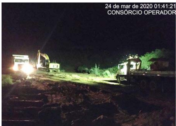
Foto 7 - Atividade de remoção da vegetação regenerada e tratamento de erosão no maciço da estrada de O&M, no lado direito hidráulico do canal, entre as estacas E-7844 e E-7865 do segmento de canal WBS 2220.
