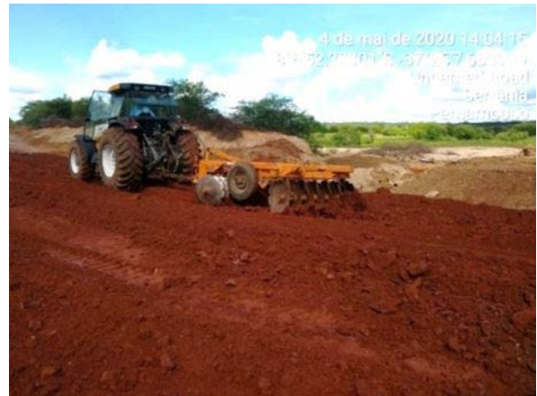
Foto 22 - Atividade de regularização do acesso e recuperação do canal enrocado no L.D hidráulico do canal, entre as estacas E-8043 e E-8045 do segmento de canal WBS 2221.
