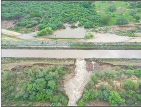
Foto 3 - ponto de transbordamento das águas do Rio Moxotó para o interior do canal do PISF no lado direito hidráulico, na altura da estaca E-8069 do segmento de canal WBS 2221
