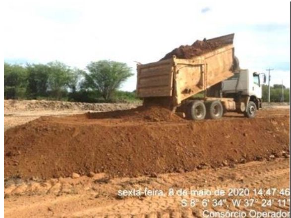
Foto 48 - Atividade de levantamento de greide das estradas de O&M e de serviço no L.D hidráulico do canal, entre as estacas E-8129 e E-8139 do segmento de canal WBS 2221.
