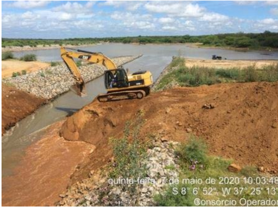
Foto 45 - Atividade de levantamento de greide das estradas de O&M e de serviço no L.D hidráulico do canal, entre as estacas E-8129 e E-8139 do segmento de canal WBS 2221.
