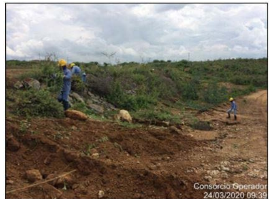
Foto 24 - Atividade de remoção da vegetação regenerada e tratamento de erosão no maciço da estrada de O&M, no lado direito hidráulico do canal, entre as estacas E-7844 e E-7865 do segmento de canal WBS 2220.
