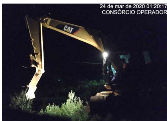
Foto 3 - Recuperação emergencial do maciço da estrada de O&M no lado direito hidráulico do canal, na altura da estaca E-7860 do segmento de canal WBS 2220.
