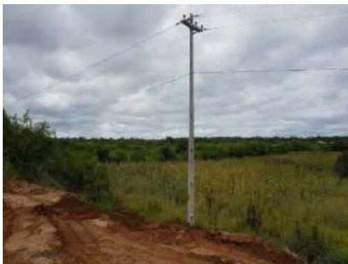
Foto 3 - A nova estrutura 05/158 completa sendo implantada 30m deslocada do lugar original devido ao novo relevo do terreno pós rompimento do canal.
