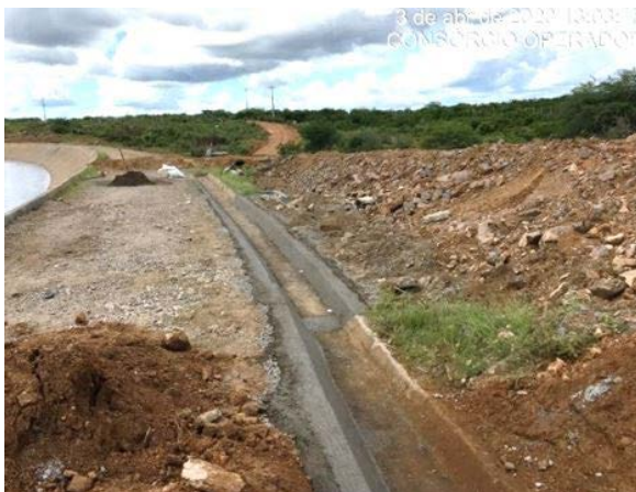
Foto 39 - Recuperação da canaleta de drenagem de águas pluviais no L.D hidráulico do canal, entre as estacas E-7856 e E-7839 do segmento de canal WBS 2220.
