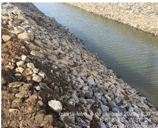
Foto 41 - Atividade de recuperação do talude enrocado do canal no L.E hidráulico, entre as estacas E-8146 e E-8149 do segmento de canal WBS 2221.
