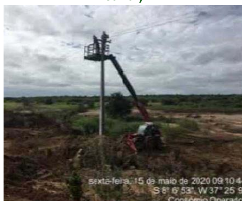
Foto 6 - Nova estrutura implantada (foi necessária uma segunda estrutura para sobrepujar o vão aberto no rompimento do canal).
