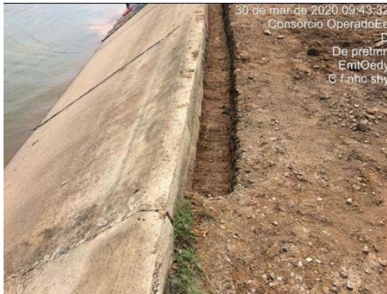
Foto 21 - Abertura da vala para direcionamento das águas pluviais no L.D hidráulico do canal, na altura da estaca E-7860 do segmento de canal WBS 2220.
