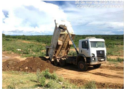
Foto 34 - Lançamento de material para tratamento de erosão do maciço da estrada de O&M, no lado direito hidráulico do canal, na altura da estaca E-7844 do segmento de canal WBS 2220.
