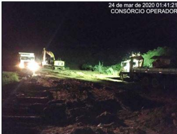
Foto 23 - Atividade de remoção da vegetação regenerada e tratamento de erosão no maciço da estrada de O&M, no lado direito hidráulico do canal, entre as estacas E-7844 e E-7865 do segmento de canal WBS 2220.
