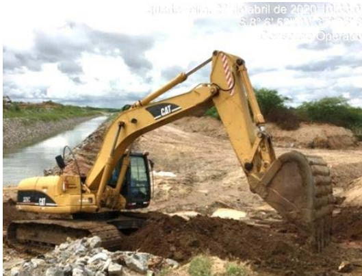
Foto 11 - Atividade de regularização do acesso e recuperação do canal enrocado no L.D hidráulico do canal, entre as estacas E-8043 e E-8045 do segmento de canal WBS 2221.
