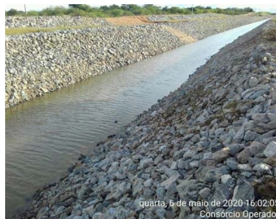
Foto 42 - Atividade de recuperação do talude enrocado do canal no L.E hidráulico, entre as estacas E-8146 e E-8149 do segmento de canal WBS 2221.
