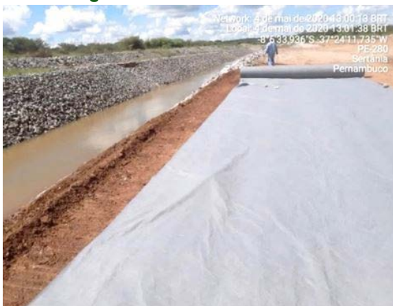
Foto 5 - Aplicação de manta bidim para recuperação do enrocamento do canal no L.D hidráulico, entre as estacas E-8131 e E-8135 do segmento de canal WBS 2221.
