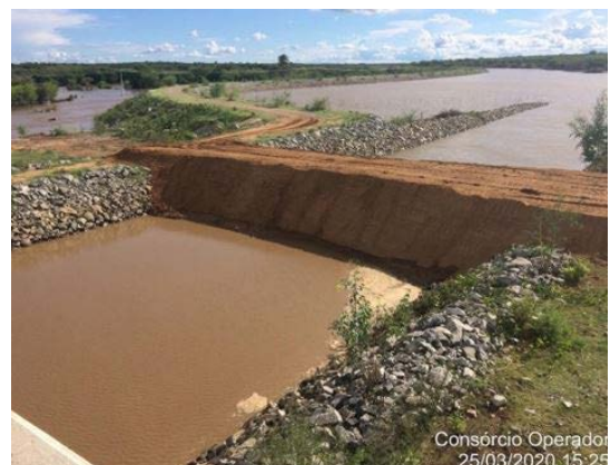
Foto 16 - Finalização da ensecadeira executada na altura da estaca E-8033 do segmento de canal WBS 2221.
