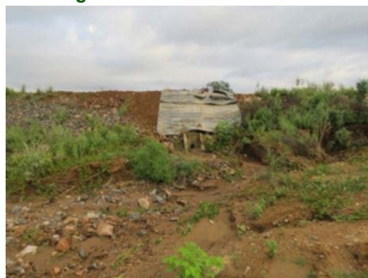
Foto 30 - Atividade de remoção da vegetação regenerada e tratamento de erosão no maciço da estrada de O&M, no lado direito hidráulico do canal, entre as estacas E-7844 e E-7865 do segmento de canal WBS 2220.
