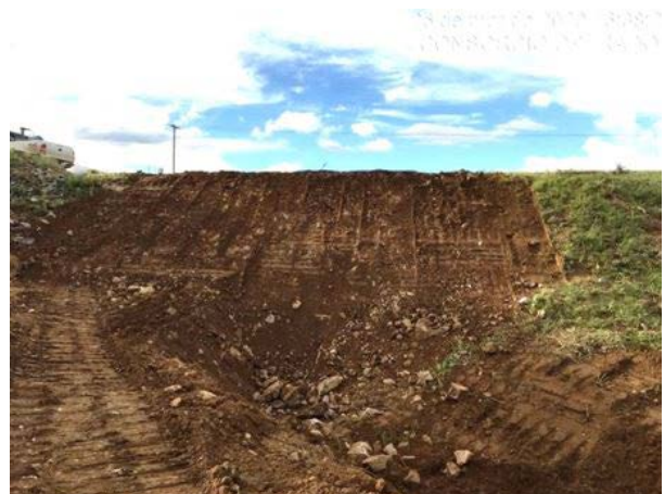
Foto 36 - Tratamento de erosão do maciço da estrada de O&M, no lado direito hidráulico do canal, na altura da estaca E-7844 do segmento de canal WBS 2220.
