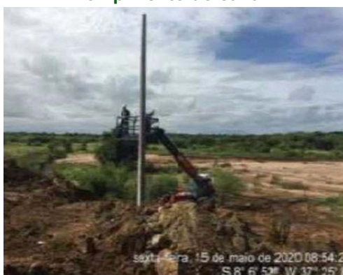
Foto 5 - A estrutura 09/158 nova completa sendo implantada 30 m deslocada do lugar original devido ao novo relevo do terreno pós rompimento do canal.
