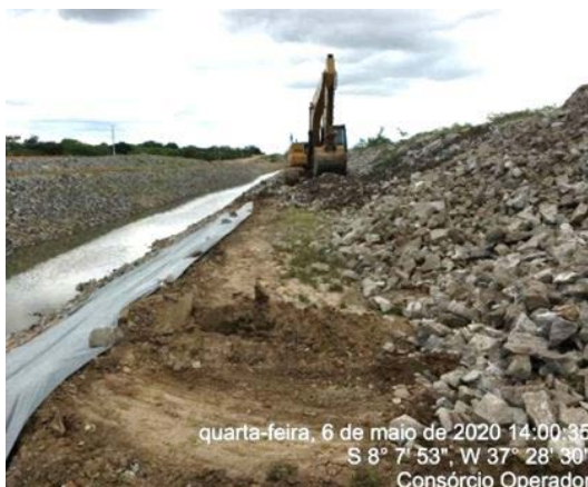
Foto 41 - Atividade de recuperação do talude enrocado do canal no L.E hidráulico, entre as estacas E-8146 e E-8149 do segmento de canal WBS 2221.
