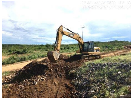
Foto 36 - Tratamento de erosão do maciço da estrada de O&M, no lado direito hidráulico do canal, na altura da estaca E-7844 do segmento de canal WBS 2220.
