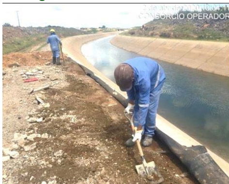
Foto 33 - Recuperação da mureta do canal no L.D hidráulico, na altura da estaca E-7856 do segmento de canal WBS 2220.
