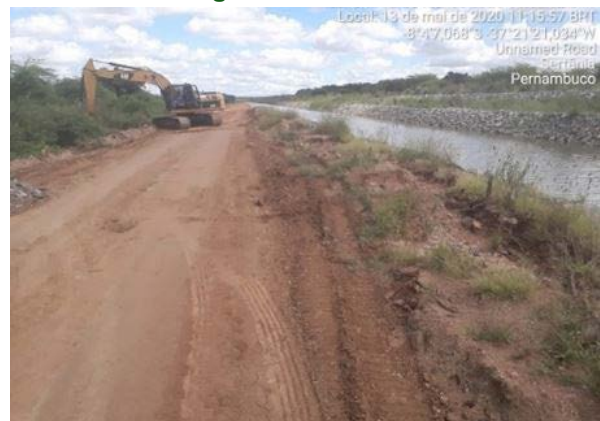
Foto 54 - Atividade de regularização do acesso e recuperação do canal enrocado no L.D hidráulico do canal, entre as estacas E-8067 e E-8078 do segmento de canal WBS 2221.
