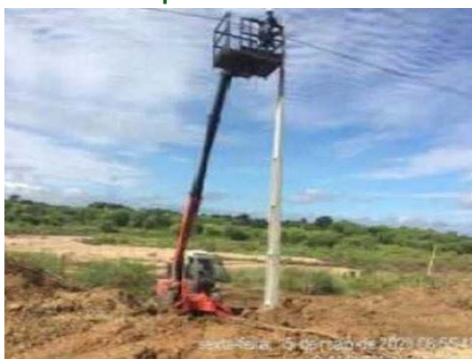
Foto 5 - A estrutura 09/158 nova completa sendo implantada 30 m deslocada do lugar original devido ao novo relevo do terreno pós rompimento do canal.
