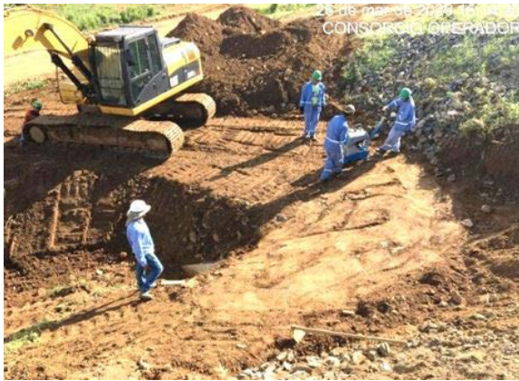
Foto 35 - Lançamento de material para tratamento de erosão do maciço da estrada de O&M, no lado direito hidráulico do canal, na altura da estaca E-7844 do segmento de canal WBS 2220.
