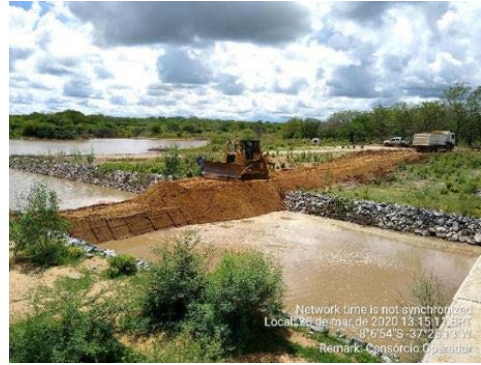
Foto 12 - Extração de material argilo-arenoso para execução de ensecadeira na altura da estaca E-8033 do segmento de canal WBS 2221.
