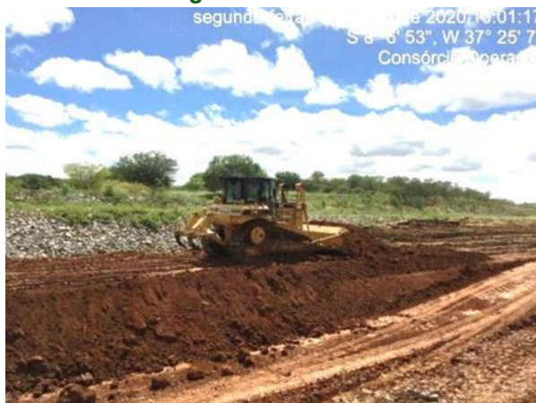
Foto 17 - Atividade de regularização do acesso e recuperação do canal enrocado no L.D hidráulico do canal, entre as estacas E-8043 e E-8045 do segmento de canal WBS 2221.
