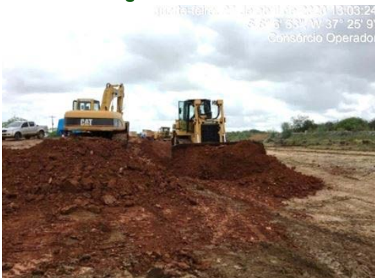
Foto 11 - Atividade de regularização do acesso e recuperação do canal enrocado no L.D hidráulico do canal, entre as estacas E-8043 e E-8045 do segmento de canal WBS 2221.
