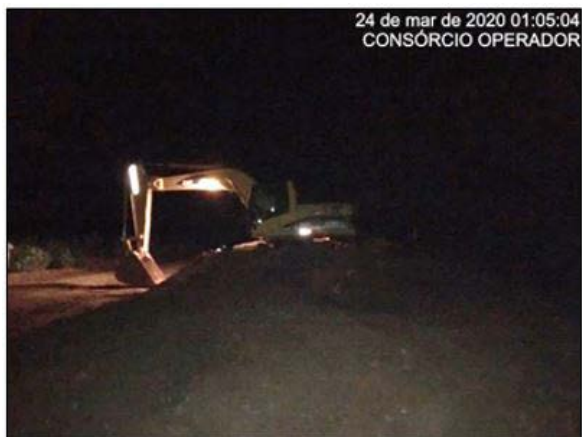
Foto 17 - Recuperação emergencial do maciço da estrada de O&M no lado direito hidráulico do canal, na altura da estaca E-7860 do segmento de canal WBS 2220.
