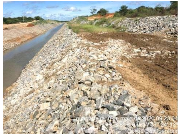
Foto 36 - Atividade de recuperação do talude enrocado do canal no L.E hidráulico, entre as estacas E-8139 e E-8140 do segmento de canal WBS 2221.
