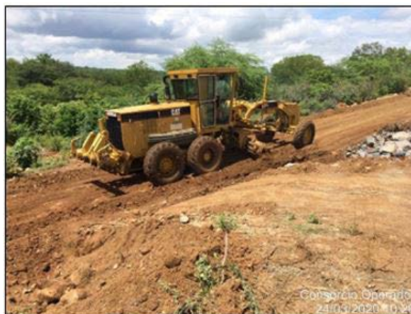
Foto 28 - Atividade de remoção da vegetação regenerada e tratamento de erosão no maciço da estrada de O&M, no lado direito hidráulico do canal, entre as estacas E-7844 e E-7865 do segmento de canal WBS 2220.
