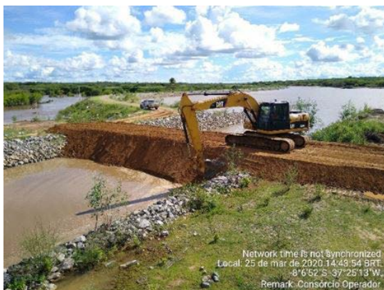
Foto 15 - Execução de ensecadeira na altura da estaca E-8033 do segmento de canal WBS 2221.
