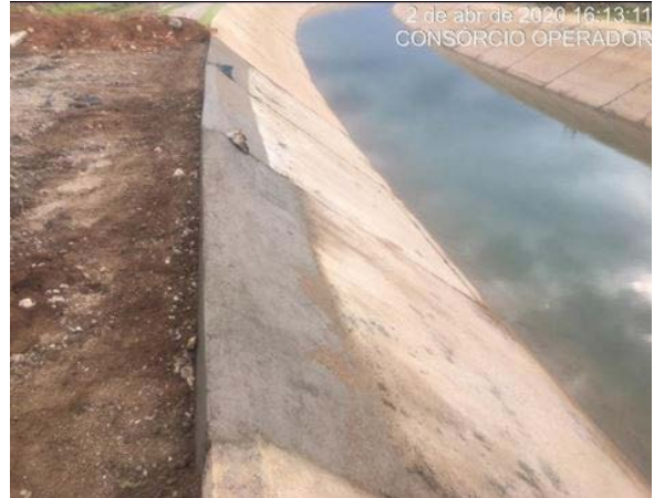
Foto 38 - Recuperação da canaleta de drenagem de águas pluviais no L.D hidráulico do canal, entre as estacas E-7856 e E-7839 do segmento de canal WBS 2220.
