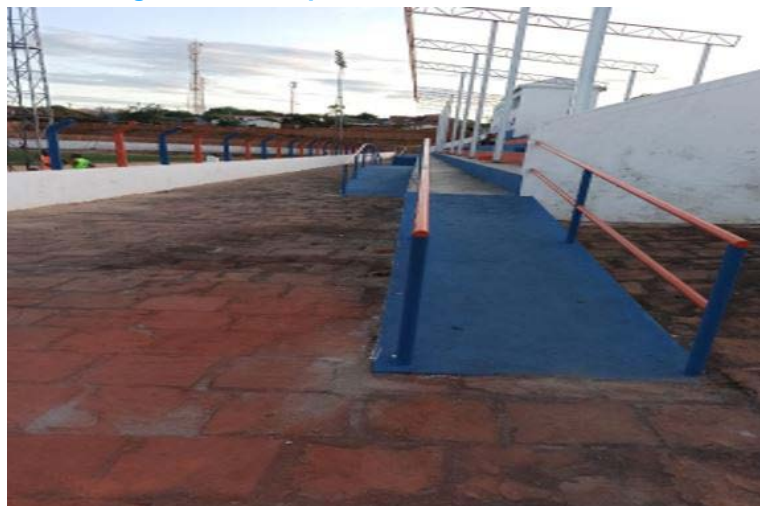
Figura 21 - Rampa do Estádio João Liberato
