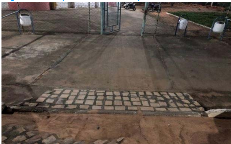
Figura 18 - Rampa do Ginásio de Esportes Severino C. Costa
